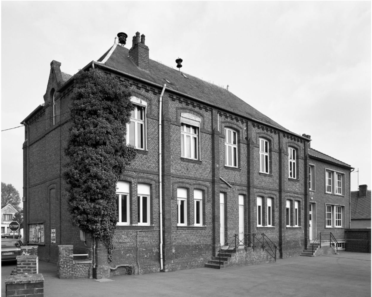
Vue de l'élevation postérieure, depuis le nord-ouest.
