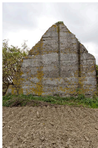
Pignon est Phot. Jean-Marc Ramette IVR31_20145904088NUCA
