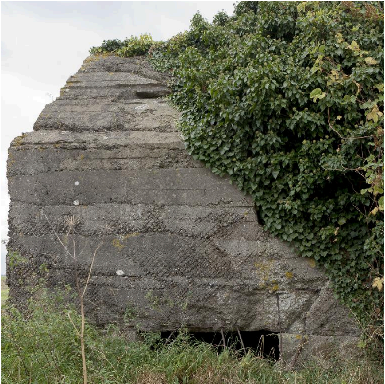
Elévation nord, détail
