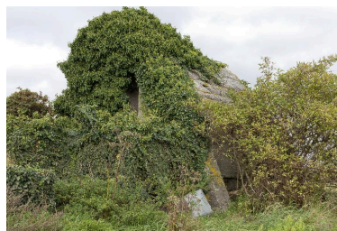
Elévation ouest, entrée de l'observatoire Phot. Jean-Marc Ramette IVR31_20145904086NUCA
