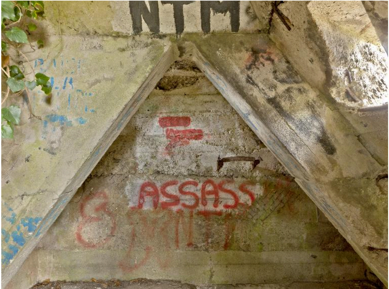
Charpente en béton armé.
