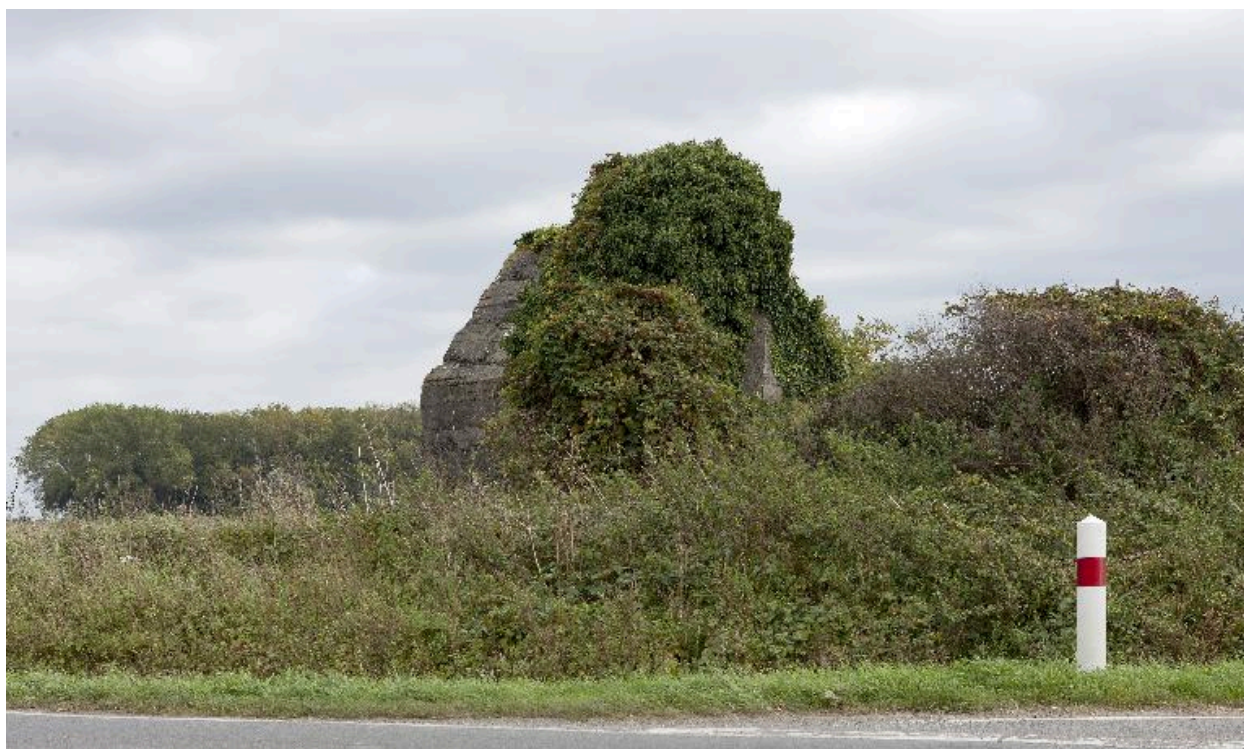
Vue générale, vers le sud
