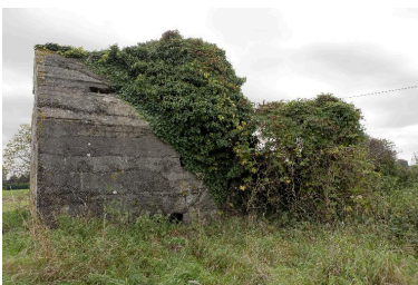
Elévation nord Phot. Jean-Marc Ramette IVR31_20145904092NUCA
