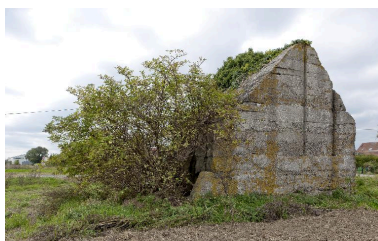
Vue vers le nord-ouest Phot. Jean-Marc Ramette IVR31_20145904087NUCA
