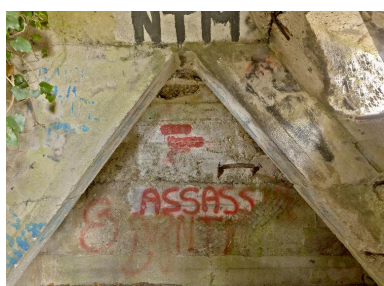
Charpente en béton armé. Phot. Jean-Marc Ramette IVR31_20145904093NUCA
