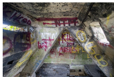
Charpente en béton armé. A gauche, un créneau de fusillade et, dessous, la niche à munitions Phot. Pierre Thibaut IVR32_20175900007NUCA
