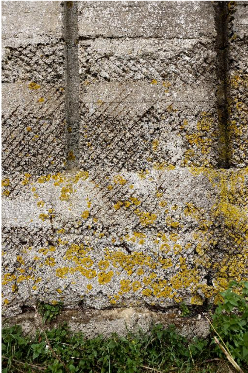
Détail du pignon est. Grillage de coffrage ?
