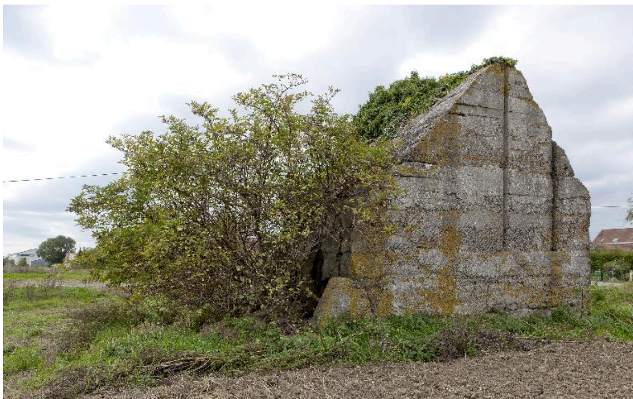
Vue vers le nord-ouest
