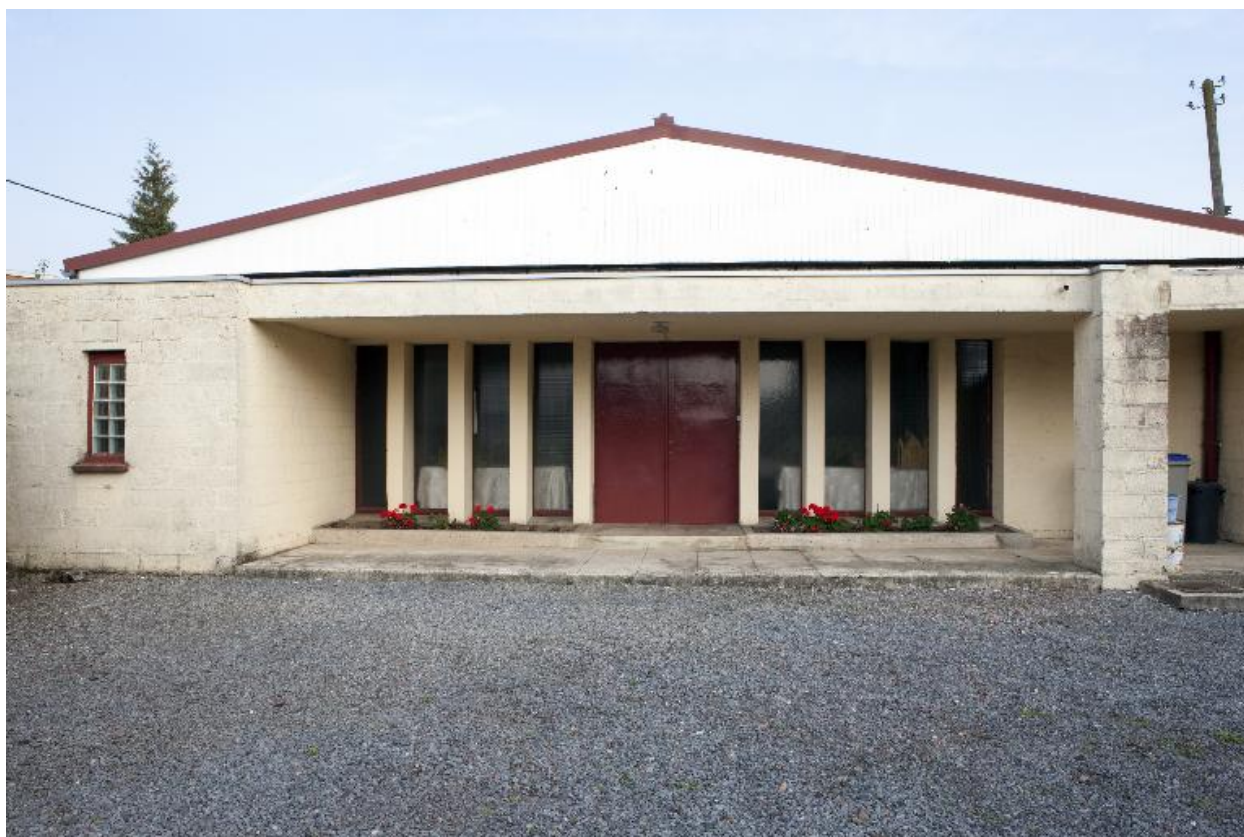
Élévation antérieure de la chapelle.
