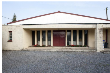
Élévation antérieure de la chapelle.
