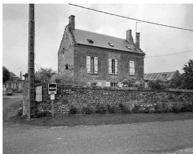
Vue générale depuis l'ouest. Phot. Thierry Lefébure IVR22_19900201116V
