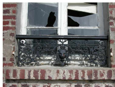
Détail d'un garde-corps en ferronnerie, rue Balzac. Phot. Elisabeth Justome IVR22_20048001525NUCA
