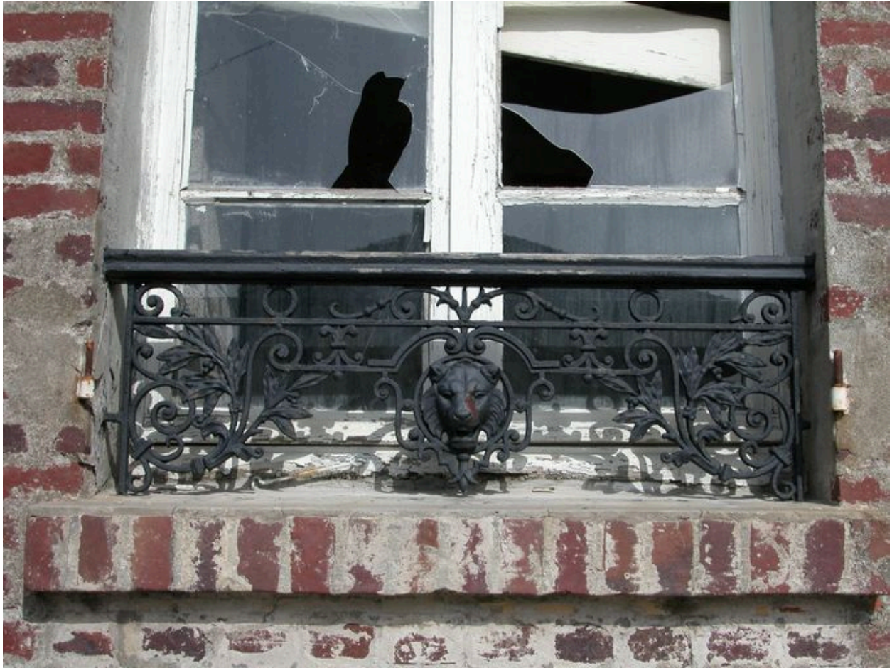
Détail d'un garde-corps en ferronnerie, rue Balzac.
