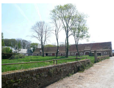
Vue des étables situées au sud de la cour. Phot. Inès Guérin IVR22_20048001070NUCA
