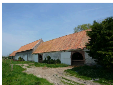
Vue postérieure des étables et de la grange situées à l'ouest de la cour. Phot. Inès Guérin IVR22_20078005669NUCA
