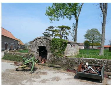
Petit bâtiment à l'angle sud-ouest de la cour. Phot. Inès Guérin IVR22_20078005667NUCA
