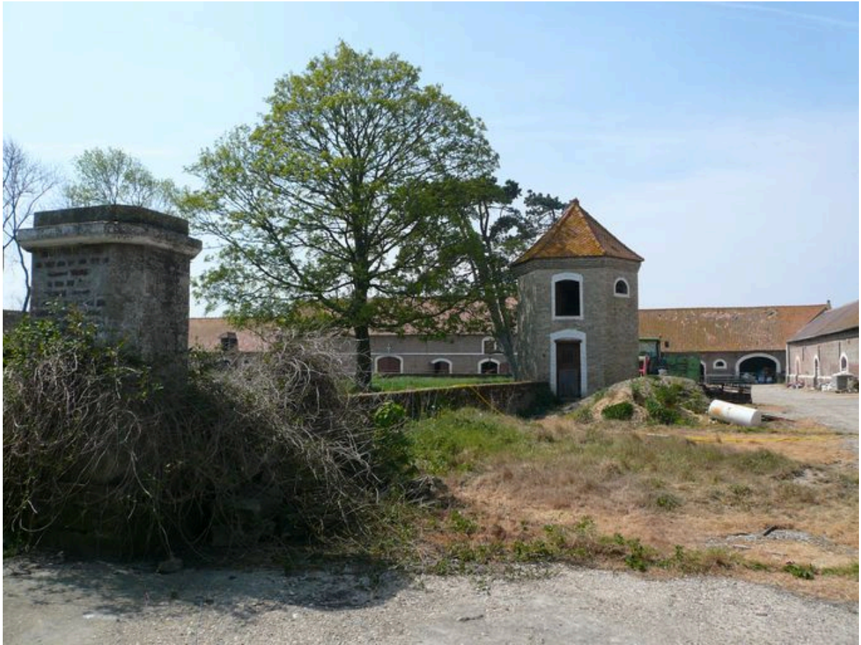
Vue du pigeonnier au nord de la cour.
