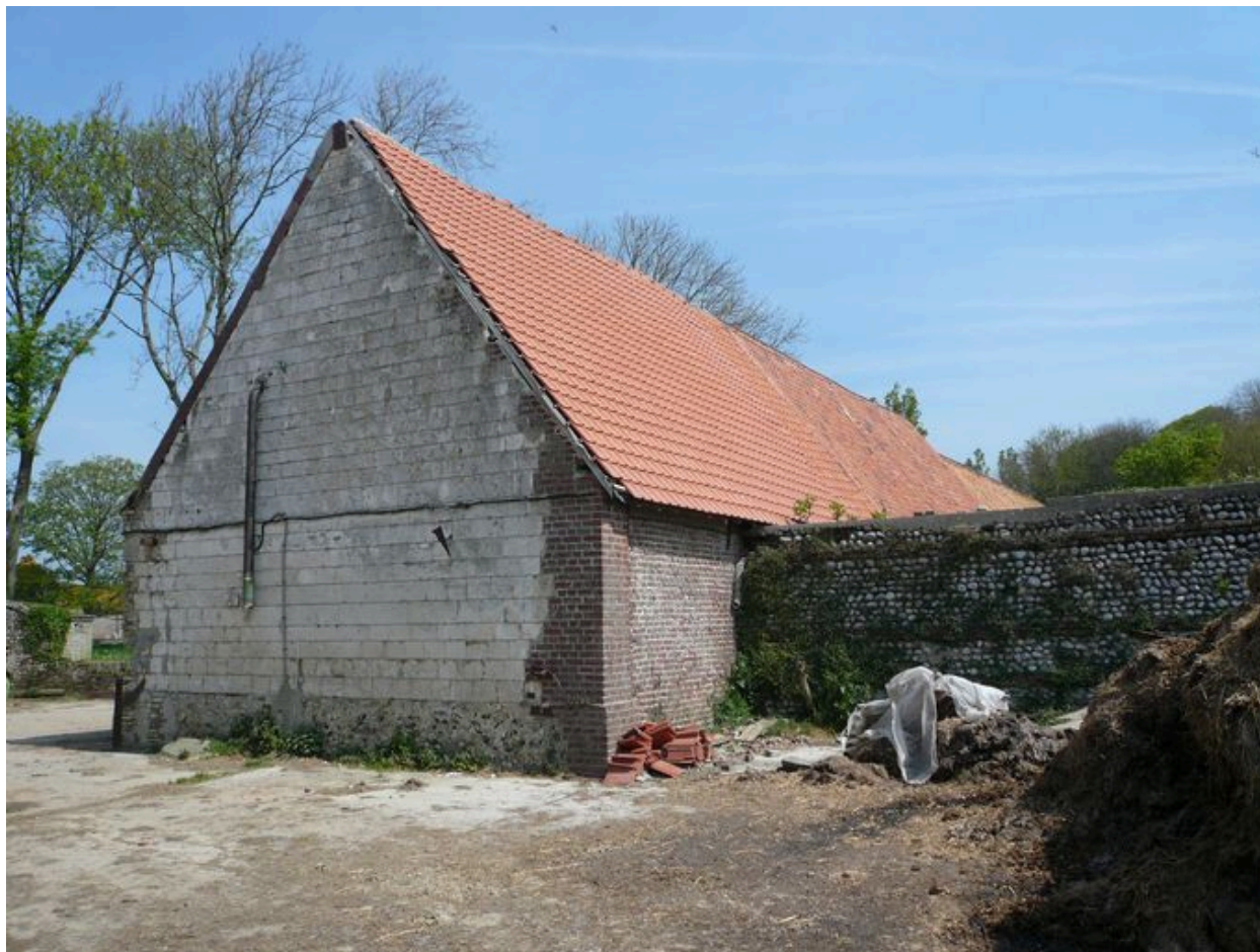
Autre vue postérieure des étables situées au sud de la cour depuis le sud-ouest avec mur de clôture en galets.
