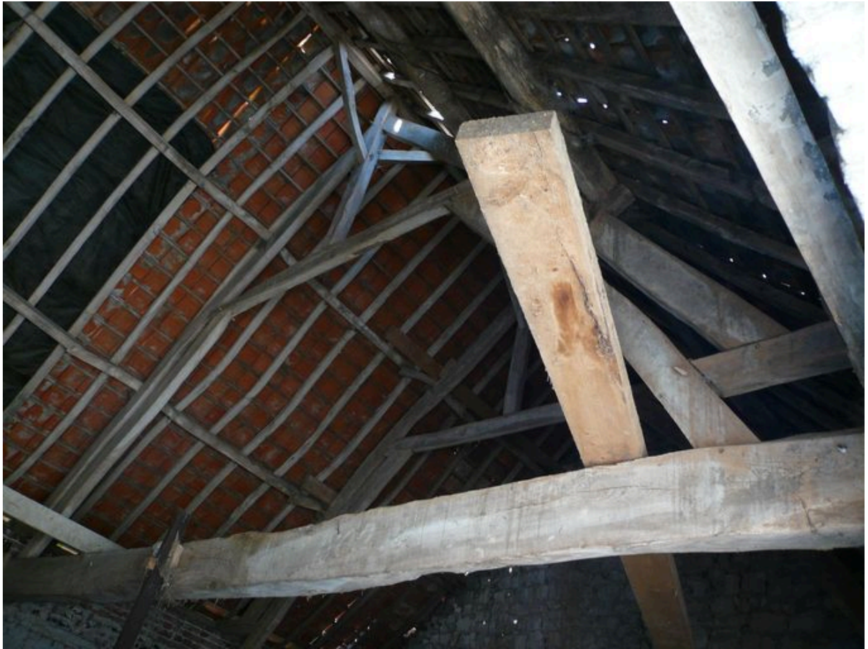
Vue de la charpente de la grange.
