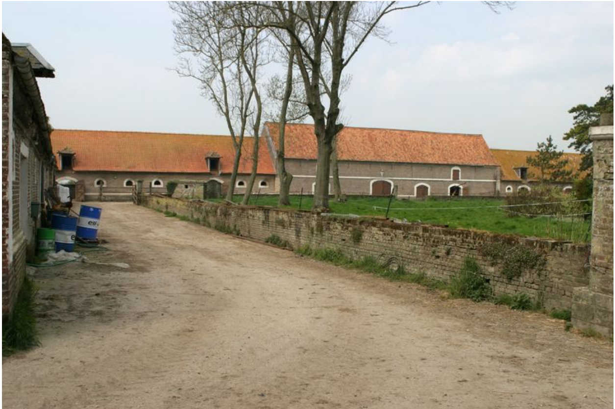
Vue des bâtiments situés à l'ouest de la cour.
