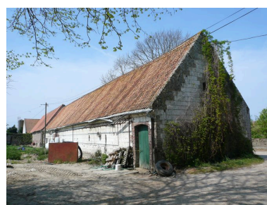
Vue postérieure des étables situées au sud de la cour depuis l'entrée au sud-est. Phot. Inès Guérin IVR22_20078005673NUCA
