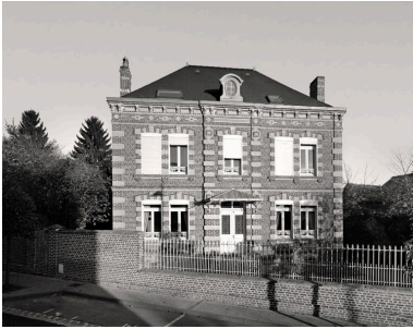
Vue de la façade sur rue. Phot. Thierry Lefébure IVR22_19990206751V
