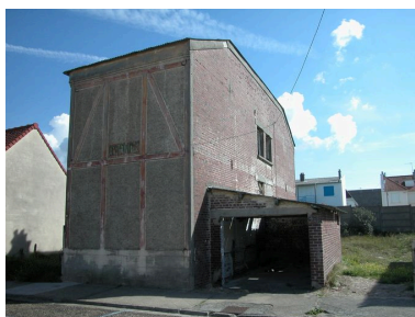
Élévation postérieure et garage accolé. Phot. Elisabeth Justome IVR22_20058003799NUCA
