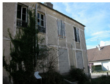
Détail d'un des deux logements, état actuel. Phot. Elisabeth Justome IVR22_20058003800NUCA
