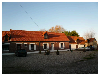
Vue du logis depuis la cour. Phot. Inès Guérin IVR22_20058006394NUCA
