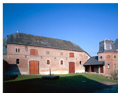
Etable et pigeonnier attenants à la porcherie. Phot. Franck Bürjes IVR22_19990201274VA
