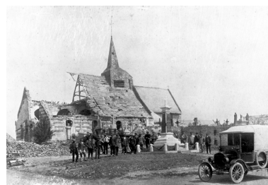
L'ancienne église de Fesmy, vers 1925 (coll. part.). Phot. Thierry Lefébure IVR22_19930200362XB
