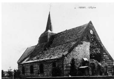
Vue d'ensemble nord-ouest de l'église, après sa destruction partielle en 1918 (coll. part.). Phot. Thierry Lefébure IVR22_19930200364XB
