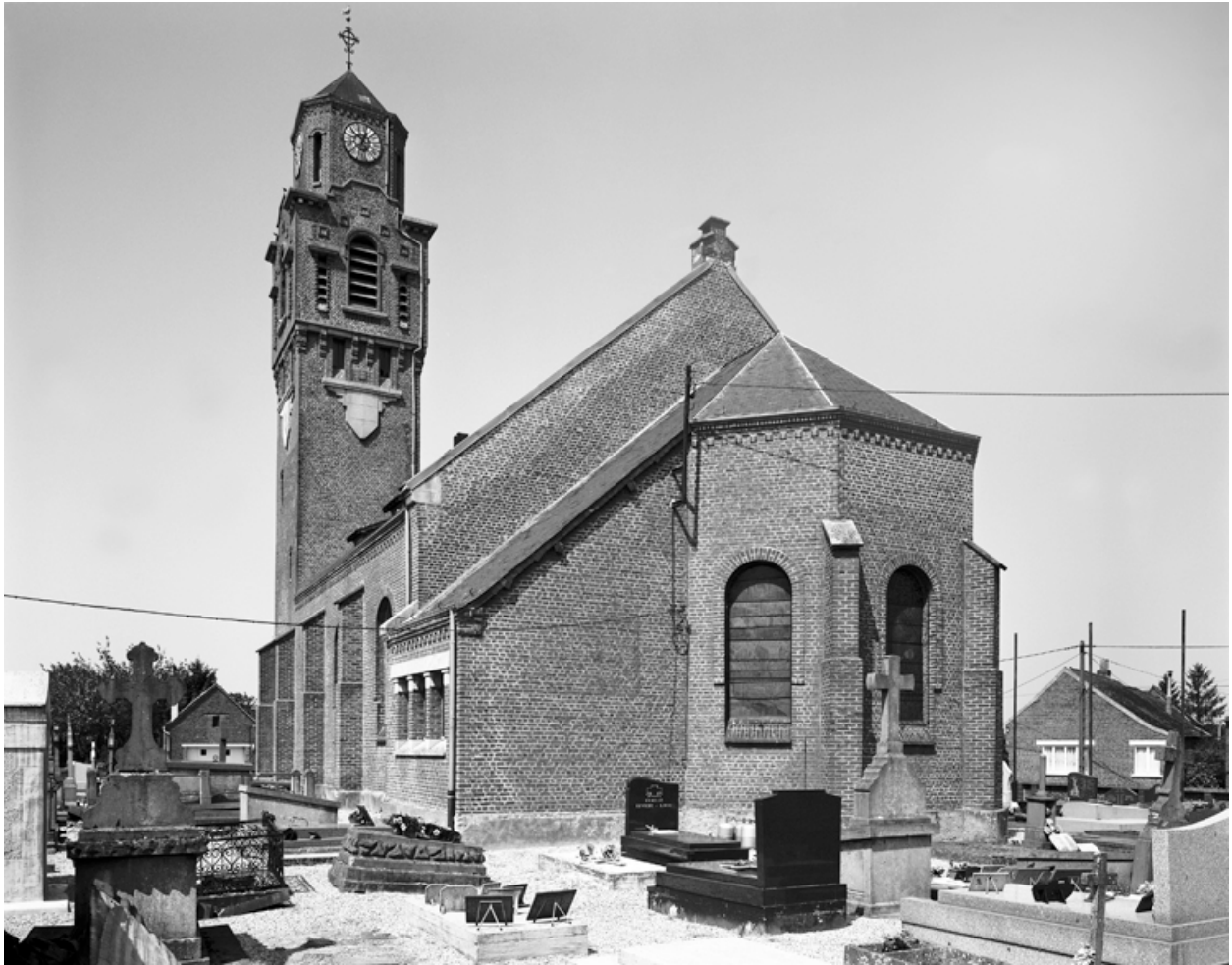
Vue générale sud-est de l'église reconstruite.
