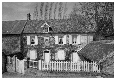
Façade orientale d'une maison, 6 rue de l'Église. Phot. Fabrice Charrondière
