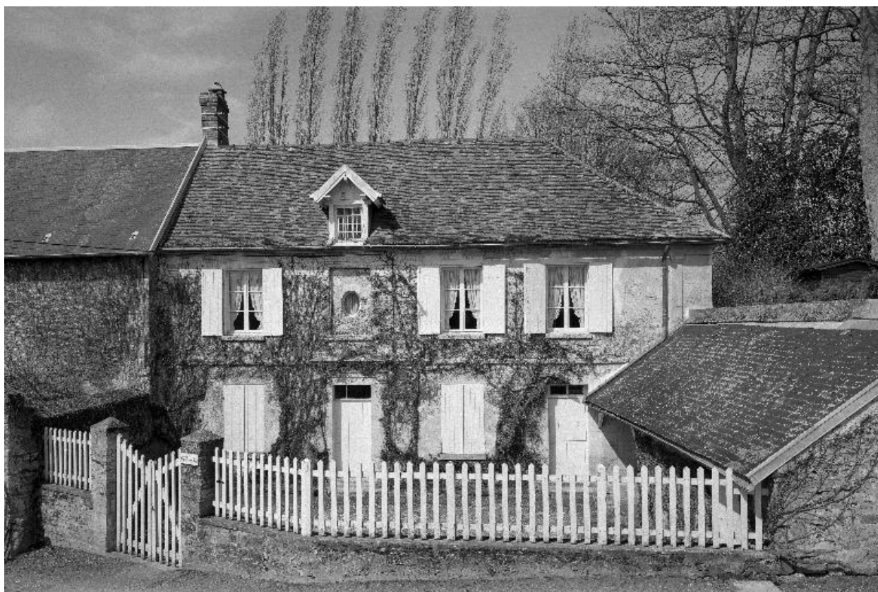
Façade orientale d'une maison, 6 rue de l'Église.
