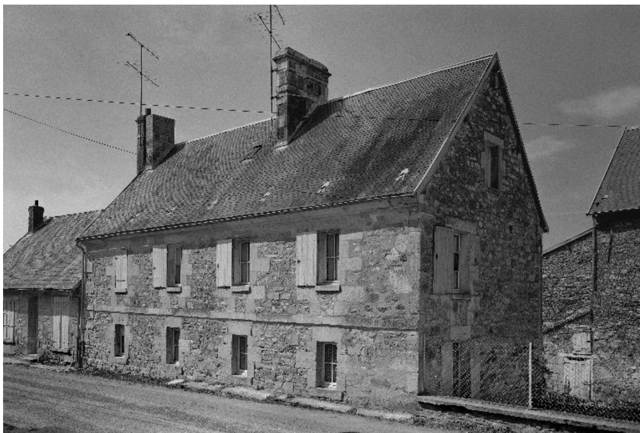
Élévation orientale d'un logis de ferme (?), 8 rue de l'Église.
