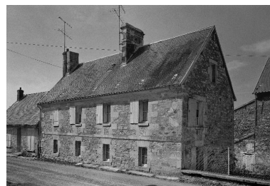
Élévation orientale d'un logis de ferme (?), 8 rue de l'Église.
