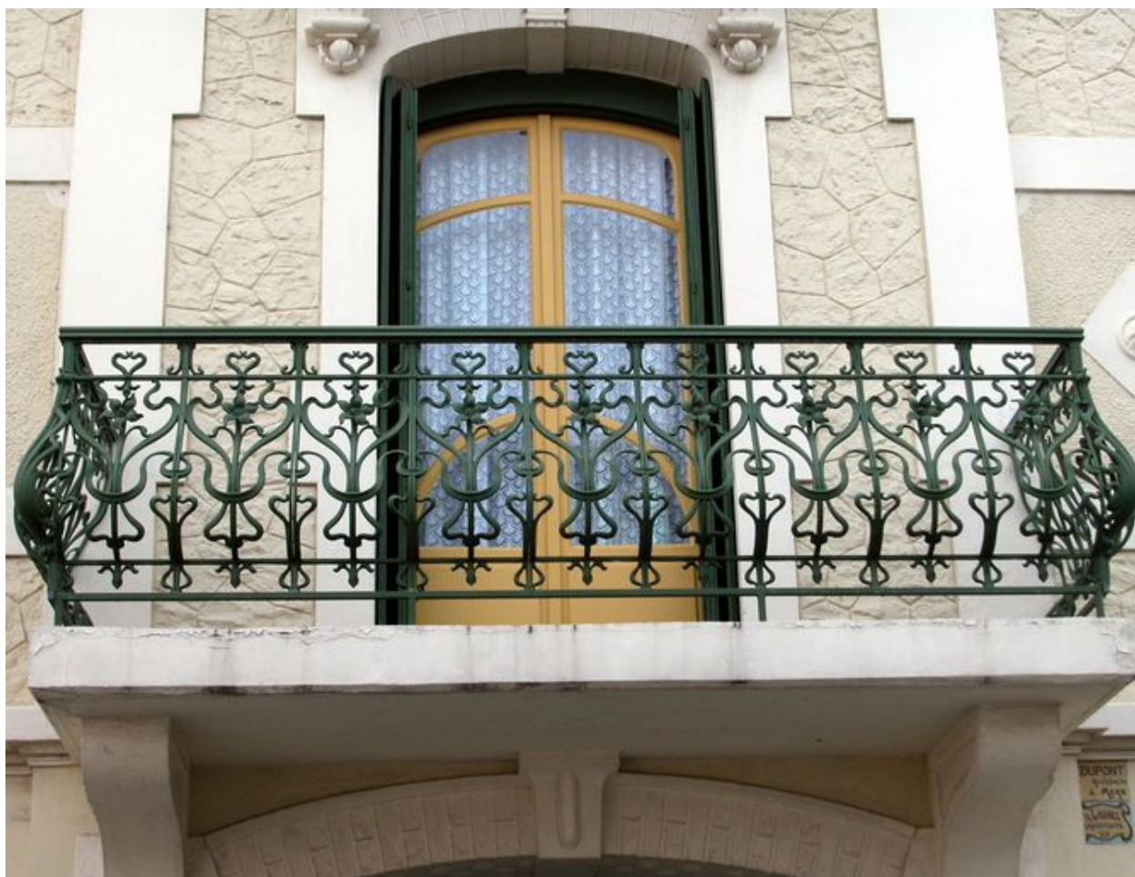
Détail du garde-corps de balcon en fonderie.
