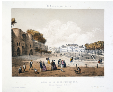
Vue générale sur square vers 1870. B.M. Boulogne-sur-Mer, Asselineau, vues pittoresques, collection La France de nos jours. Phot. Jean-Michel Périn IVR31_19886200440XA
