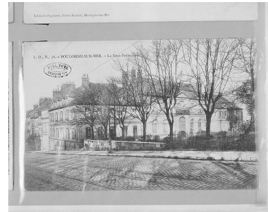
Vue générale d'angle, vers 1900, carte postale. B.M. Boulogne-sur-Mer, division cartes postales. Repro. Caudroit Philippe IVR31_19926201061XB
