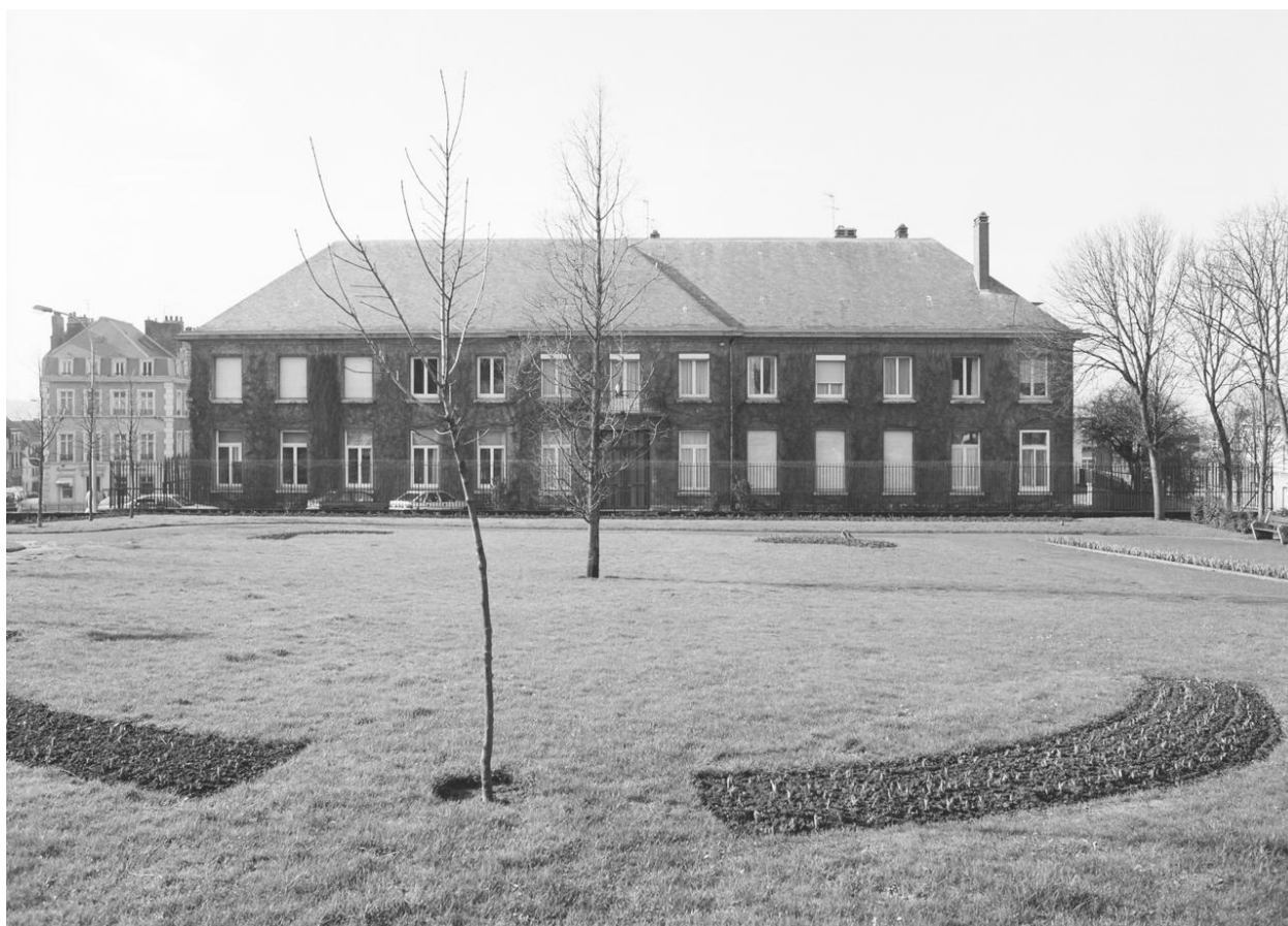
Façade sur square du bâtiment actuel.
