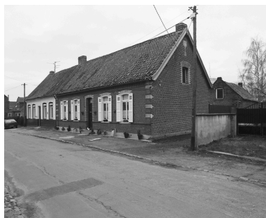
Vue générale. Phot. Philippe Dapvril IVR31_20045900078X
