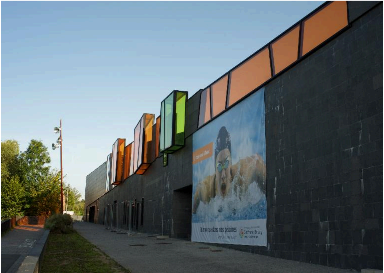
Façade d'entrée (sud).
