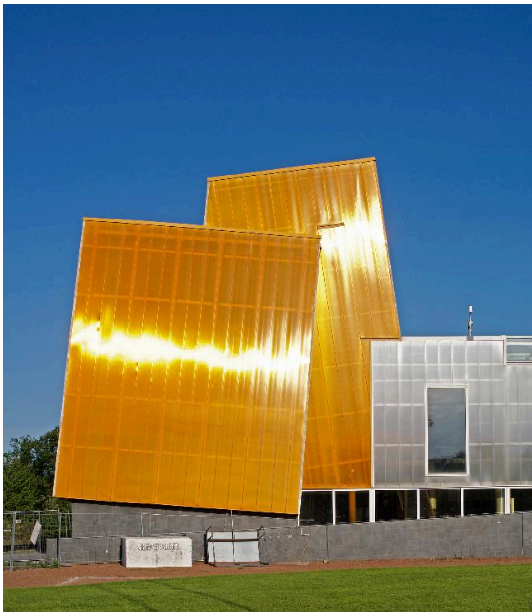
Pignon sud-est : ces cubes orange abritent le toboggan.
