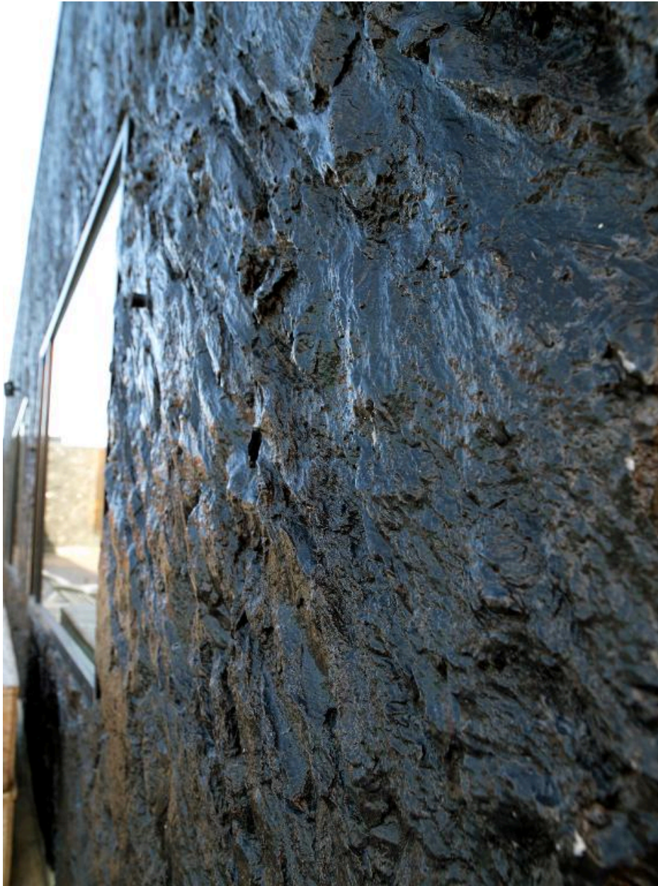
Détail de la paroi de la terrasse solarium, traitée de manière à évoquer de la roche charbonneuse.
