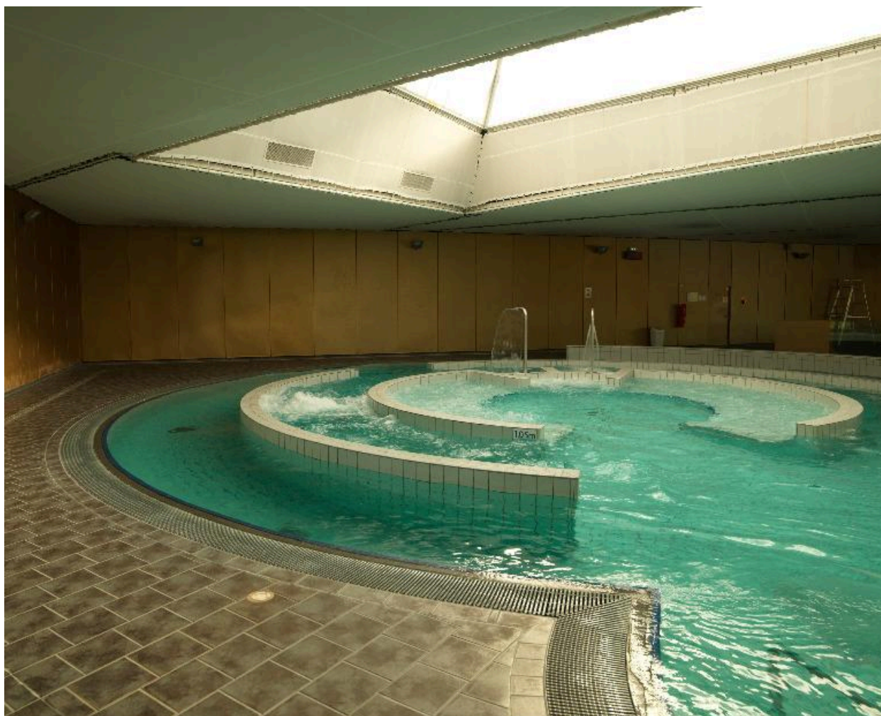
Détail du bassin de balnéothérapie, qui comprend jets, bains bouillonnants et rivière à contre-courant.
