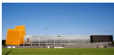
Façade est, face au stade. Phot. Marie-Laure Monnehay-Vulliet IVR32_20176200648NUC2A
