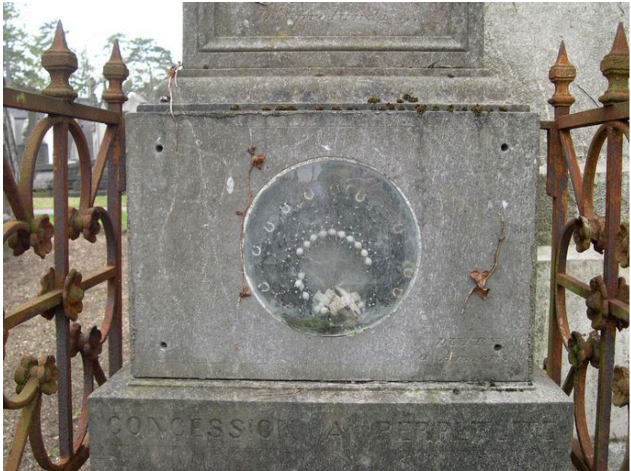
Vue de détail sur la base.
