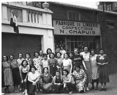
Vue de situation avec les ateliers de confection Chapuis à l'arrière plan. Photographie vers 1950 (coll. Part.). Phot. Bouvet Hubert IVR32_20196200964NUC1A
