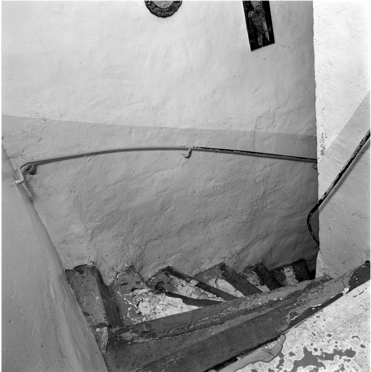
Vue de l'escalier.
