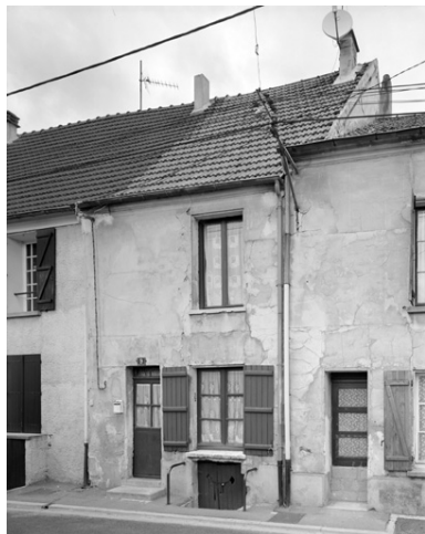
Vue de la façade sur rue. Phot. Thierry Lefébure IVR22_19950200394V
