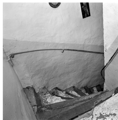
Vue de l'escalier. Phot. Thierry Lefébure IVR22_19950203314X
