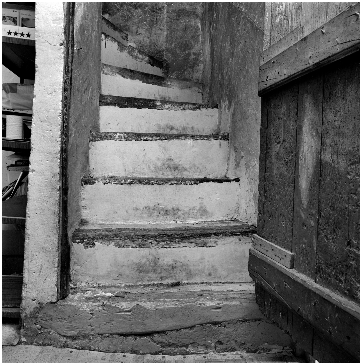
Vue de l'escalier du grenier.
