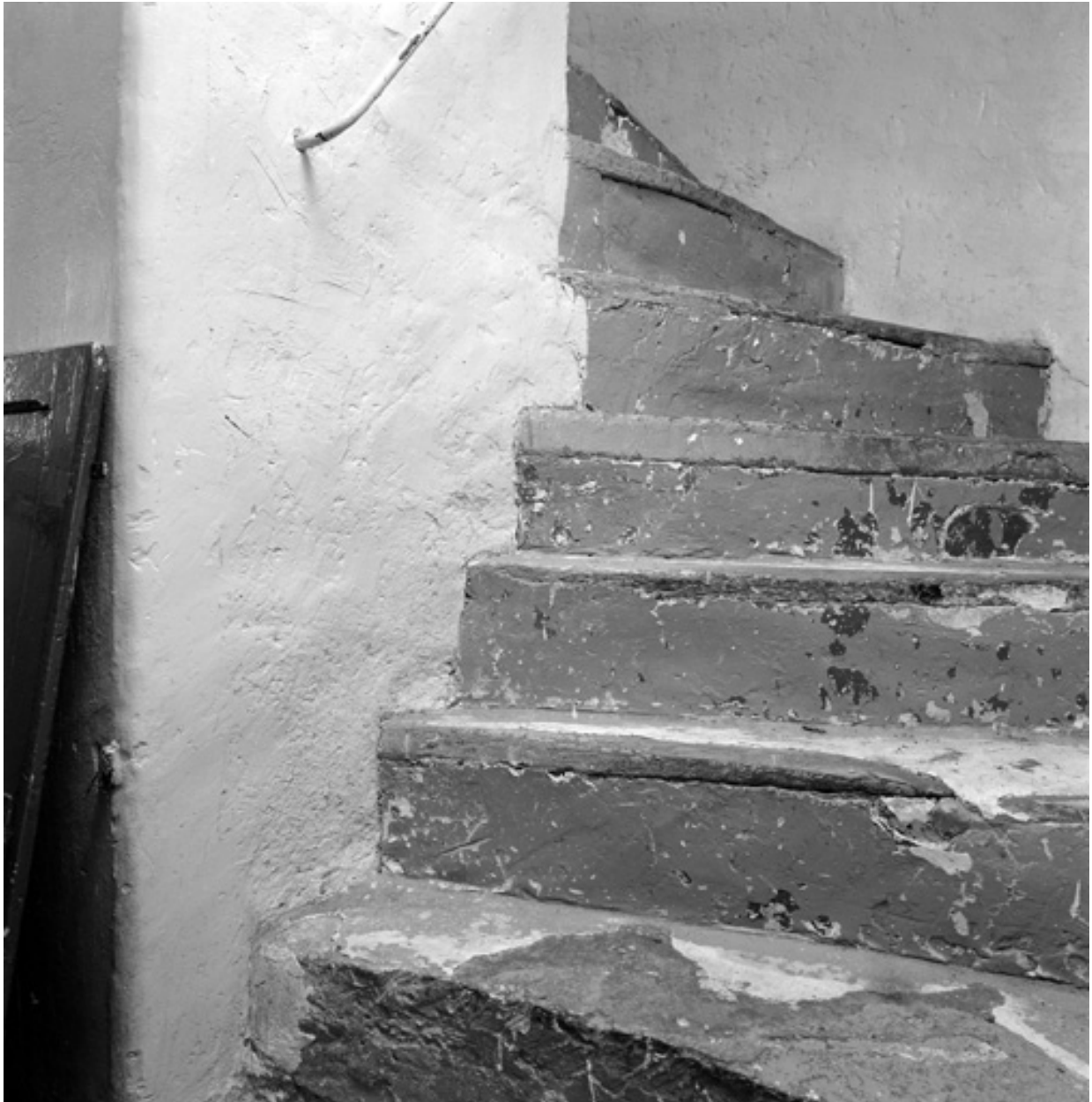
Départ de l'escalier principal.
