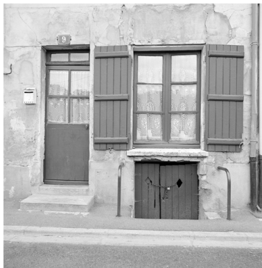
Détail de la façade : l'entrée de la cave. Phot. Thierry Lefébure IVR22_19950200416X
