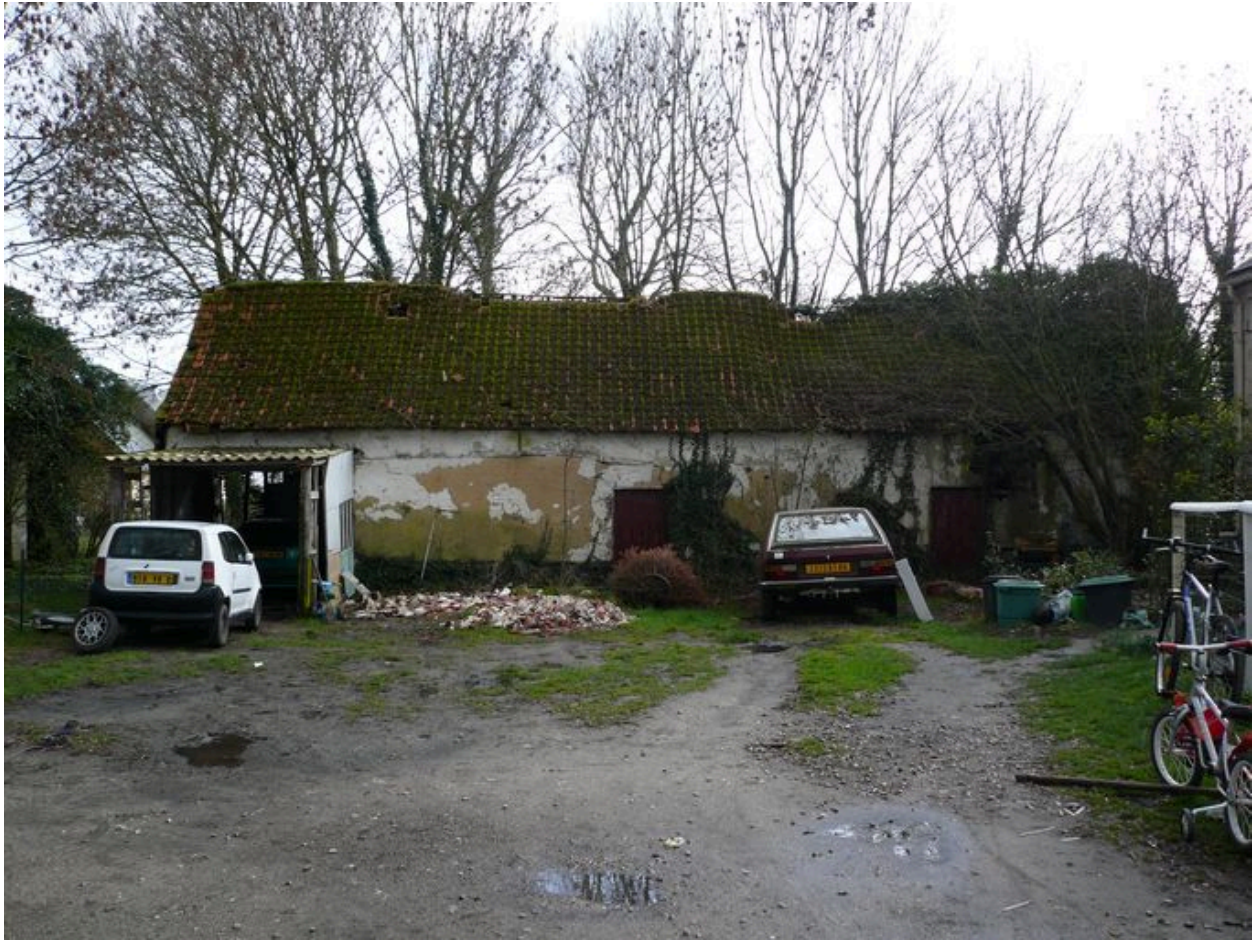
Vue des étables en fond de cour.
