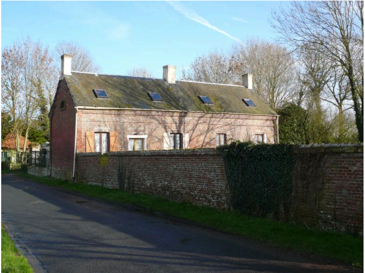
Vue postérieure du logis.
