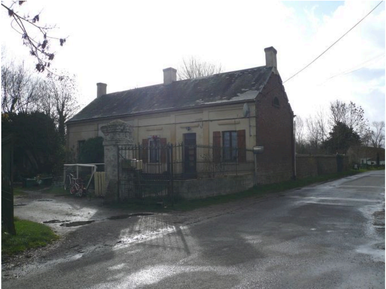
Vue du logis depuis la rue.
