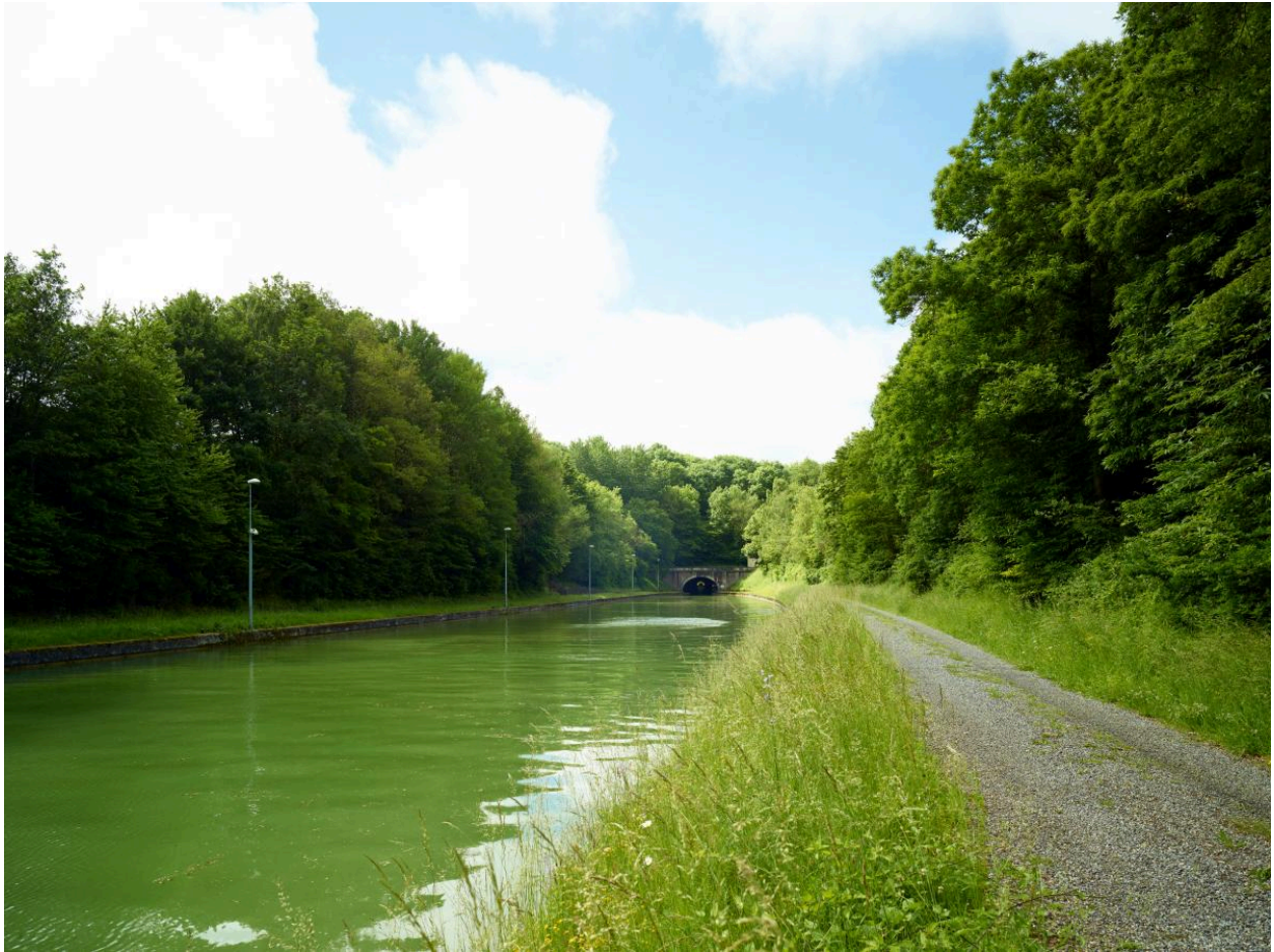
Tête d'entrée nord et voie de circulation.
