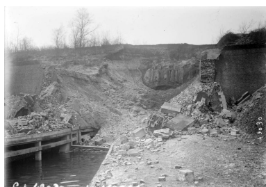
Tête nord du souterrain de la Panneterie minée. Photographie, 1917. Phot. Pierre Thibaut IVR32_20226000879NUCAB
