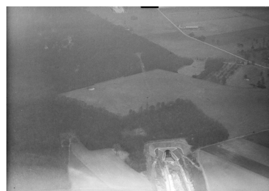
Vue aérienne des environs de la tête nord du souterrain de la Panneterie sur le canal du Nord à Libermont (Oise) reprise durant le second chantier du canal, 1963. Phot. Pierre Thibaut IVR32_20226000880NUCAB
