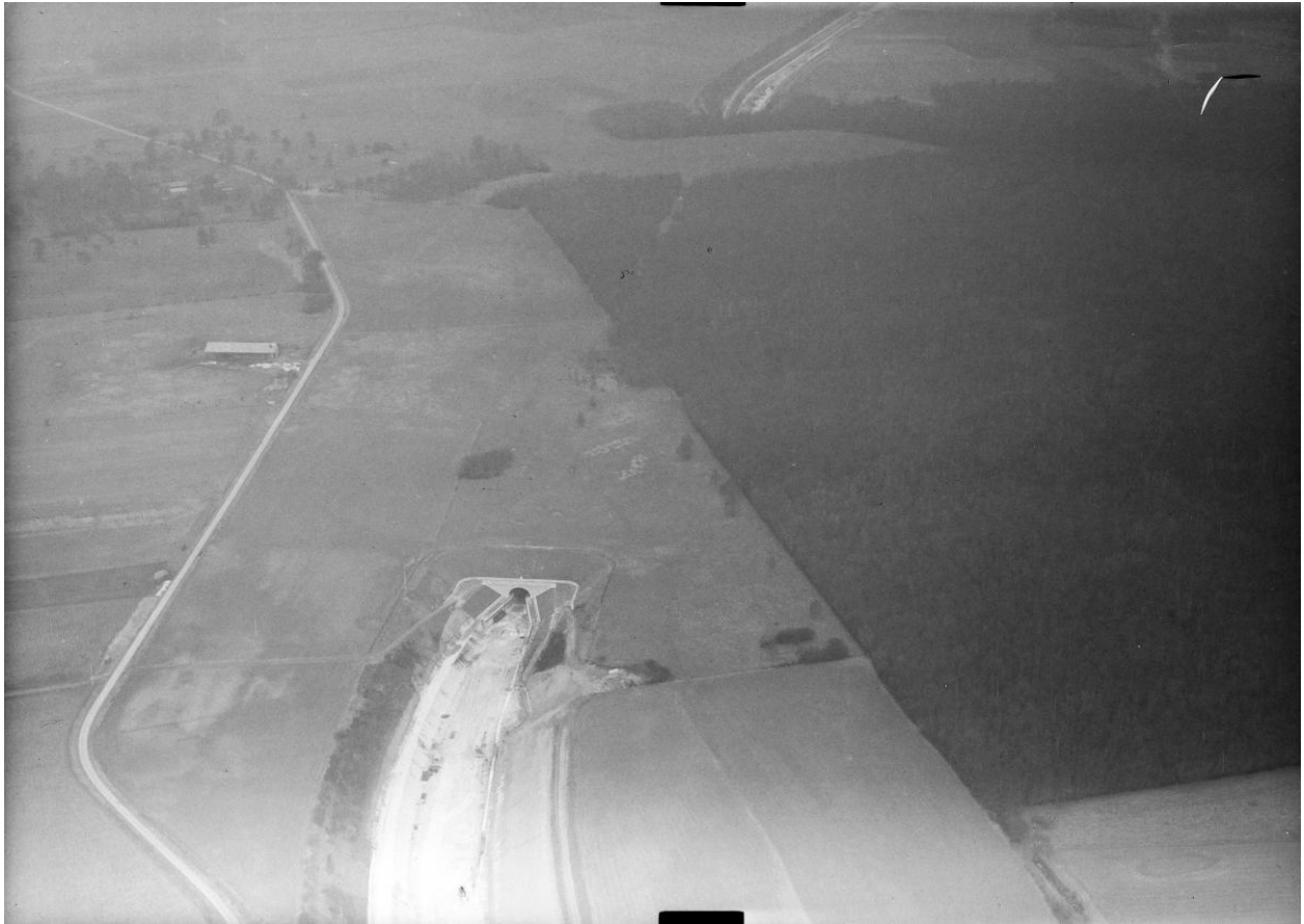
Vue aérienne de la tête sud du souterrain de la Panneterie en cours de restructuration, à proximité de Frétoy-le-Château (Oise), 1963.
