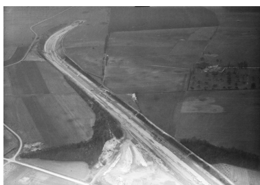
Vue aérienne aux environs de la tête sud du tunnel de la Panneterie, 1963. Phot. Pierre Thibaut IVR32_20226000874NUCAB
