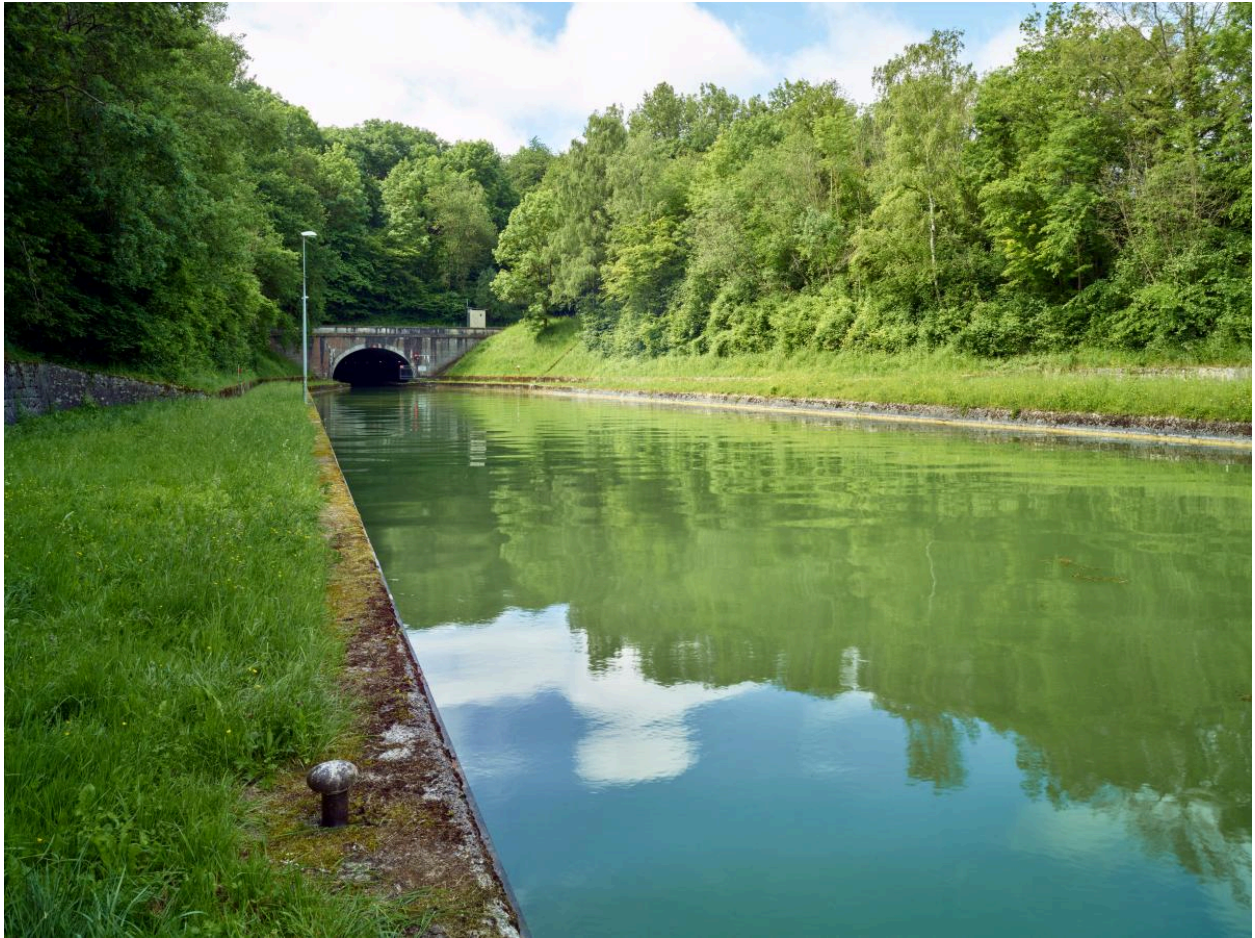
Tête d'entrée nord et quai de stationnement des péniches.
