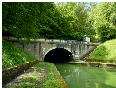
Tête d'entrée nord. Phot. Pierre Thibaut IVR32_20216000805NUCA
