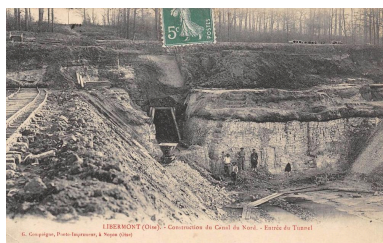
Entrée nord du souterrain de la Panneterie en cours de construction à Libermont (Oise). Carte postale, entre 1908 et 1914. Phot. Pierre Thibaut IVR32_20226000876NUCAB
