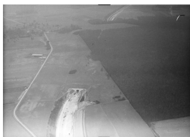
Vue aérienne de la tête sud du souterrain de la Panneterie en cours de restructuration, à proximité de Frétoy-le-Château (Oise), 1963. Phot. Pierre Thibaut IVR32_20226000881NUCAB
