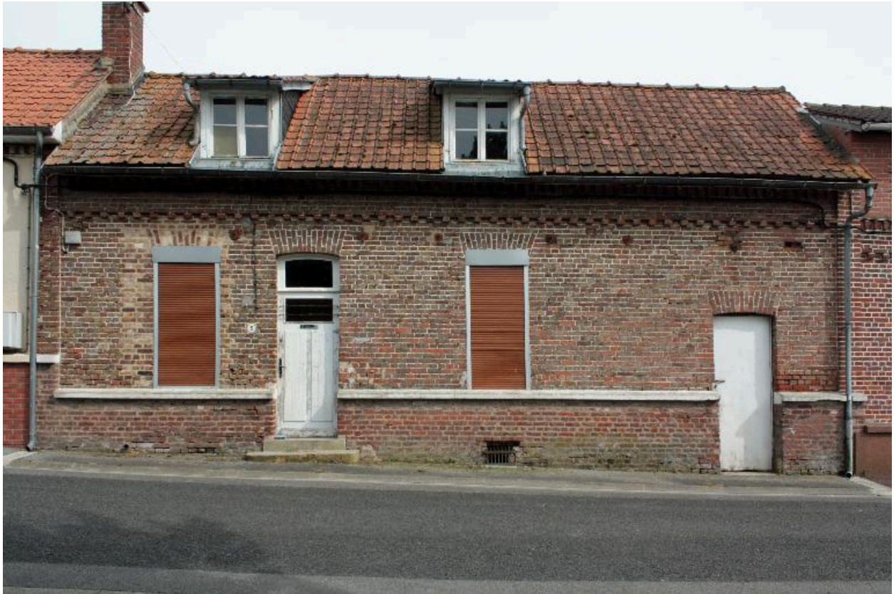
Façade sur rue du logement du n°5 rue Beldame.
