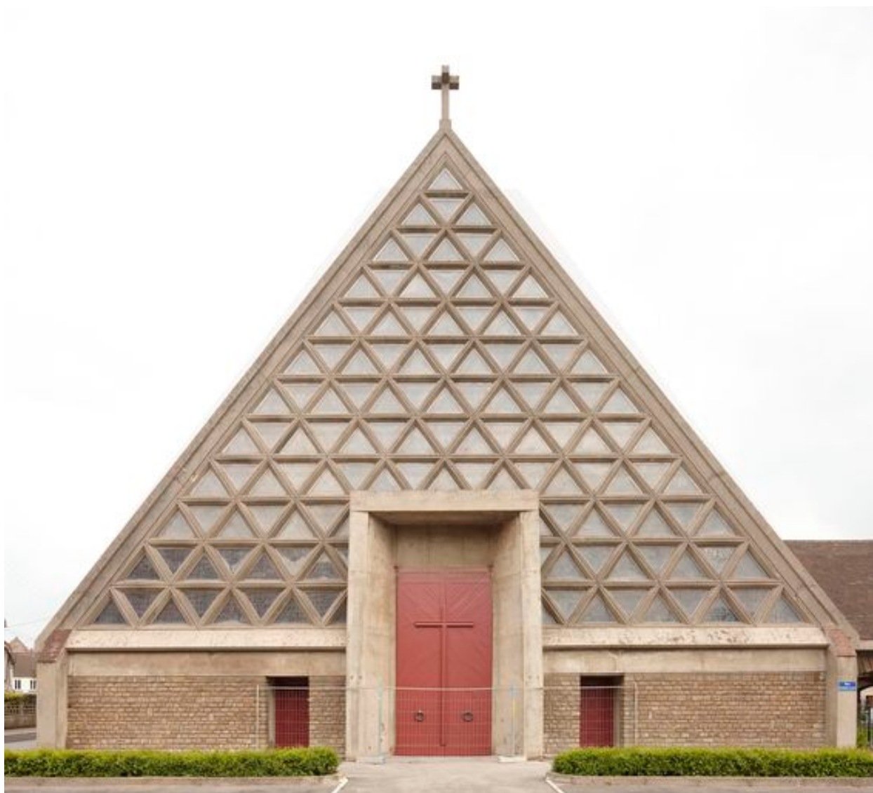
Vue de la façade.
