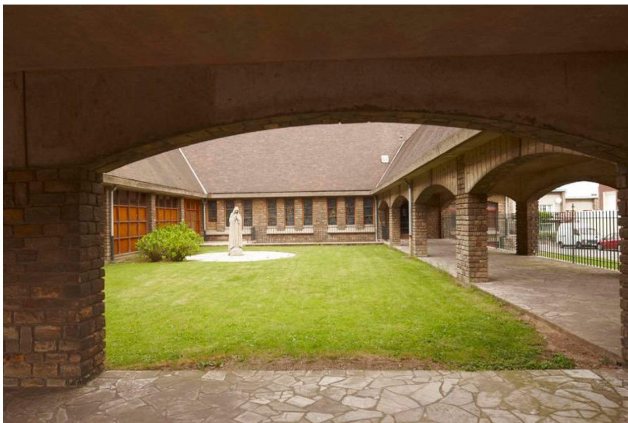
Vue des galeries.
