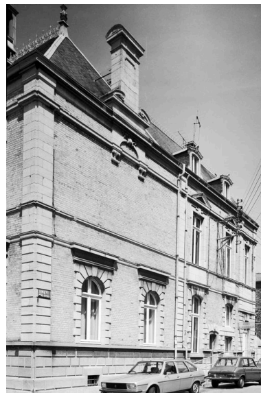
Elévation latérale, rue du Prince-Impérial, en 1981. Phot. Eric Dessert IVR31_19816203905X
