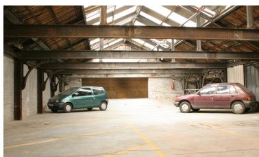
Ancien atelier d'usinage. Phot. Frédéric Pillet IVR22_20050206093NUCA
