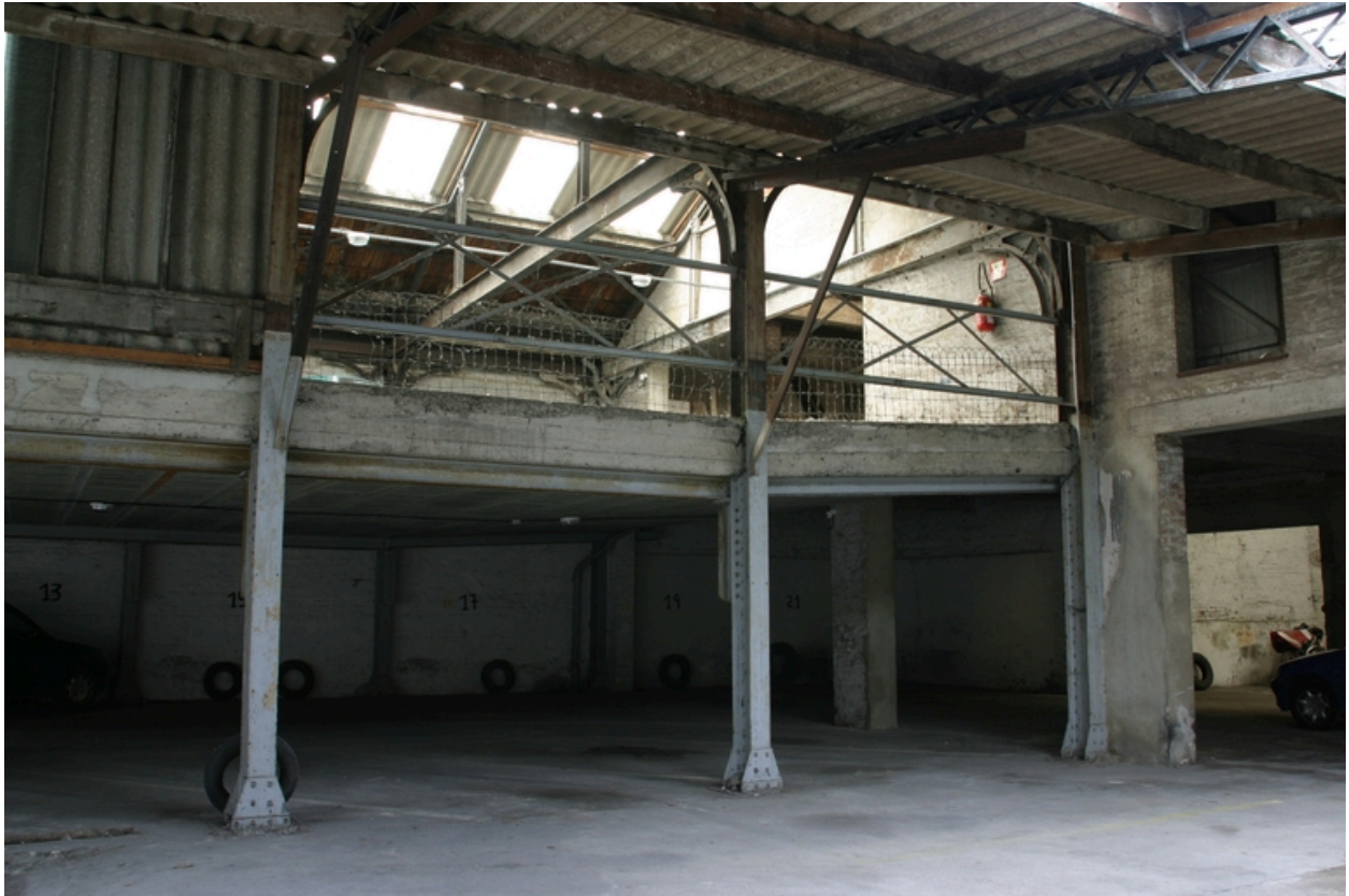
Ancien atelier d'usinage, scindé en deux niveaux lors du réaménagement en parking.
