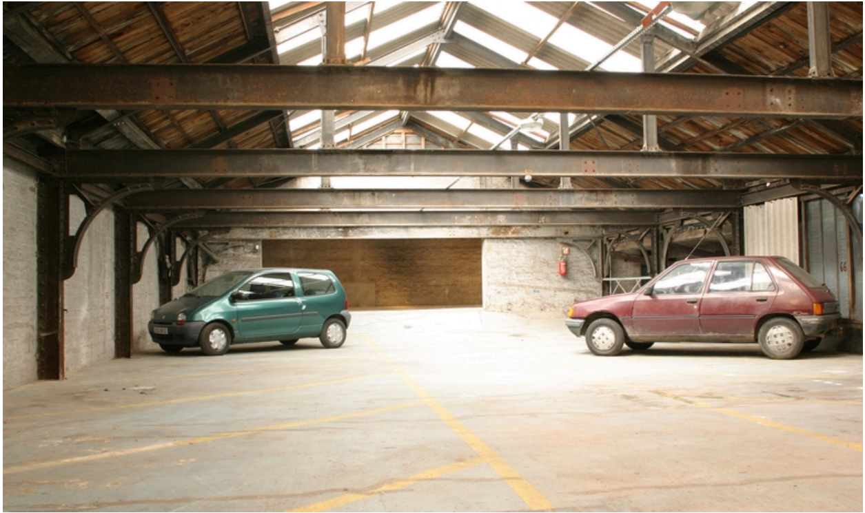
Ancien atelier d'usinage.
