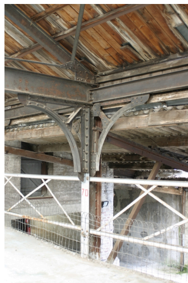
Ancien atelier d'usinage : détail du système constructif. Phot. Frédéric Pillet IVR22_20050206094NUCA
