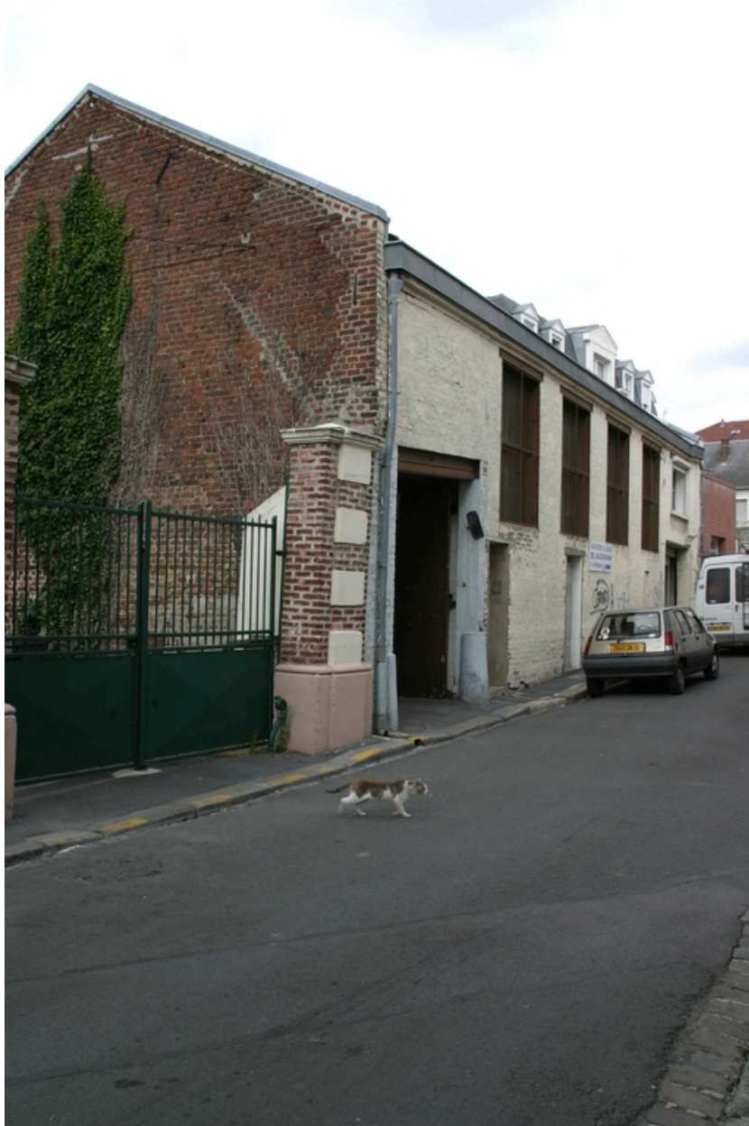
Entrée des ateliers, rue des Bouloirs : atelier de fonderie de fonte.
