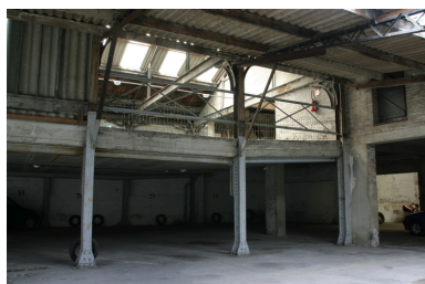
Ancien atelier d'usinage, scindé en deux niveaux lors du réaménagement en parking. Phot. Frédéric Pillet IVR22_20050206092NUCA
