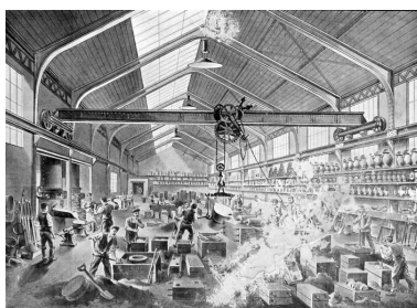
Fonderie de fer, 1902 (AC Saint-Quentin). Phot. Pilet Frédéric IVR22_20050205806NUCAB
