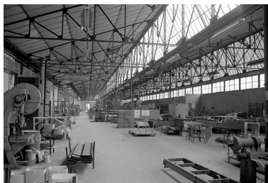
Atelier de fabrication, vue intérieure.
