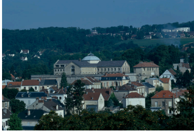
La prison vue de la plate-forme du château. Phot. Thierry Lefébure IVR22_19940200802XA
