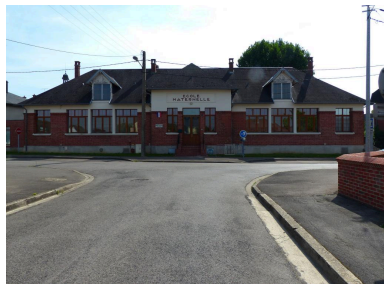
Vue depuis la rue Lafayette. Phot. Isabelle Barbedor IVR32_20170205601NUCA
