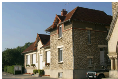
Vue générale. Phot. Inès Guérin IVR22_20030203143NUCA
