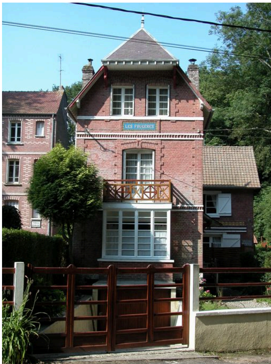
Vue d'ensemble depuis la route du Vieux-Chêne.
