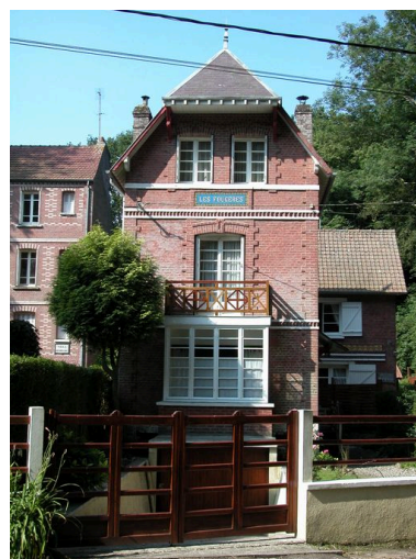
Vue d'ensemble depuis la route du Vieux-Chêne.
