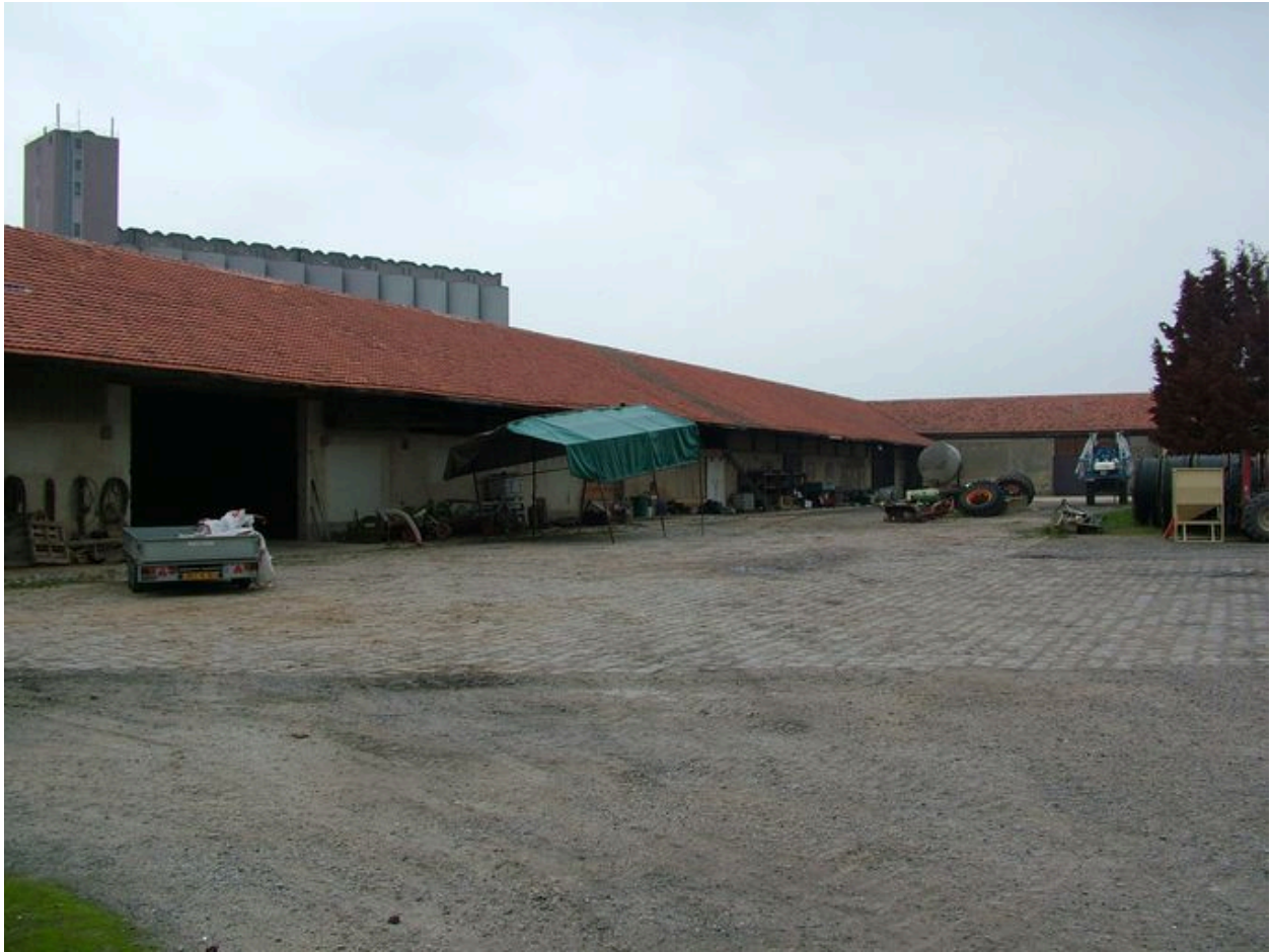
Vue de la cour intérieure et des bâtiments agricoles distribués autour.
