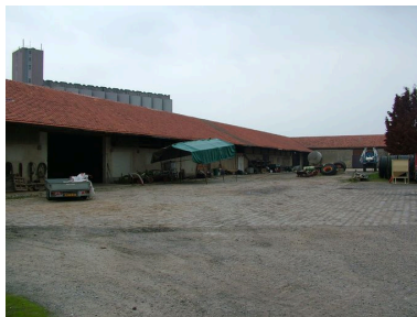
Vue de la cour intérieure et des bâtiments agricoles distribués autour. Phot. Irwin Leullier IVR22_20050201043NUCA
