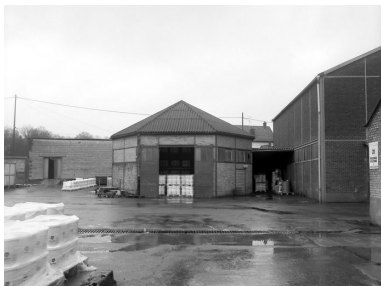
Magasin industriel, pignon est.
