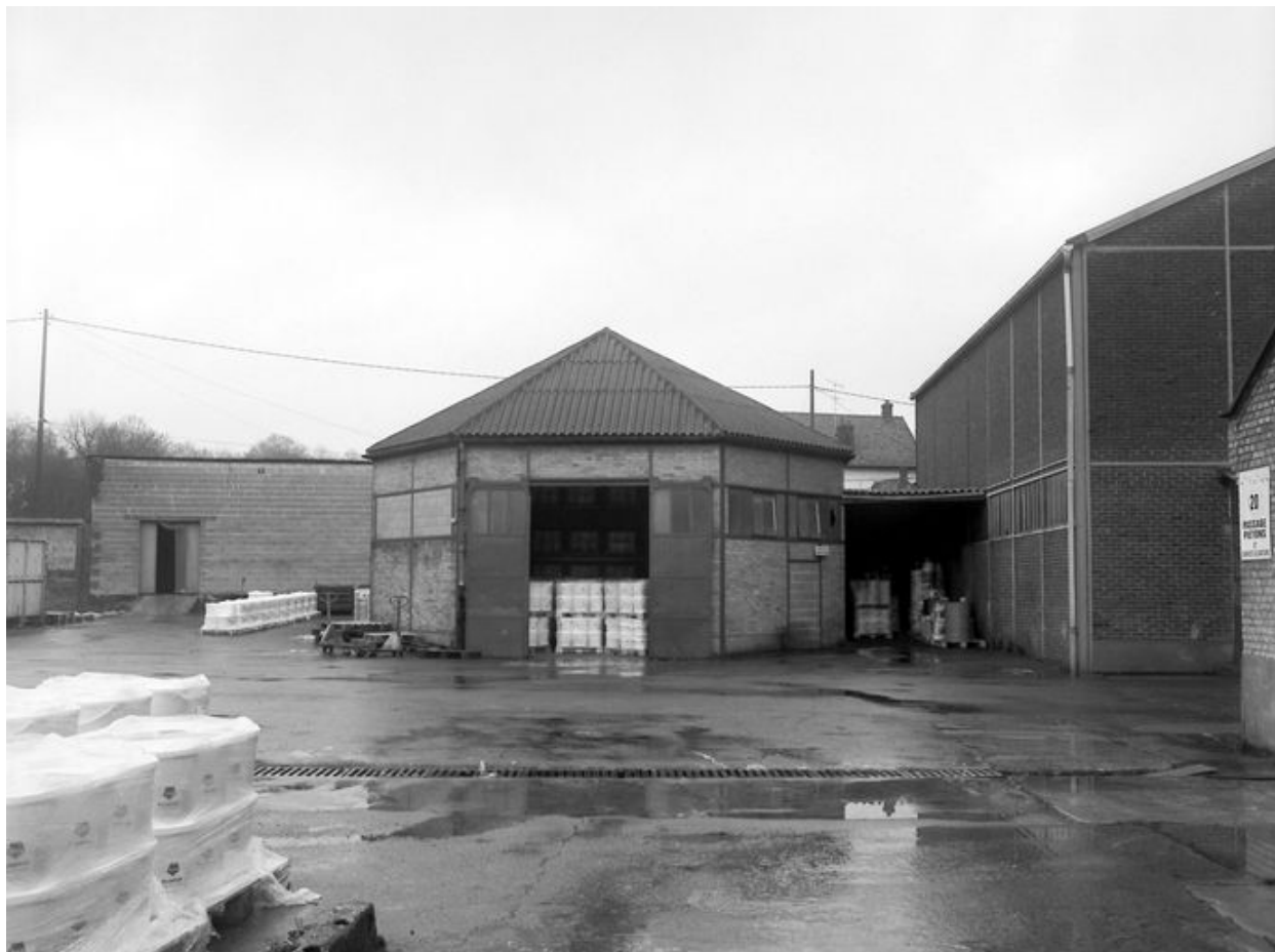
Magasin industriel, pignon est.
