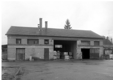
Salle des machines, façade latérale nord.
