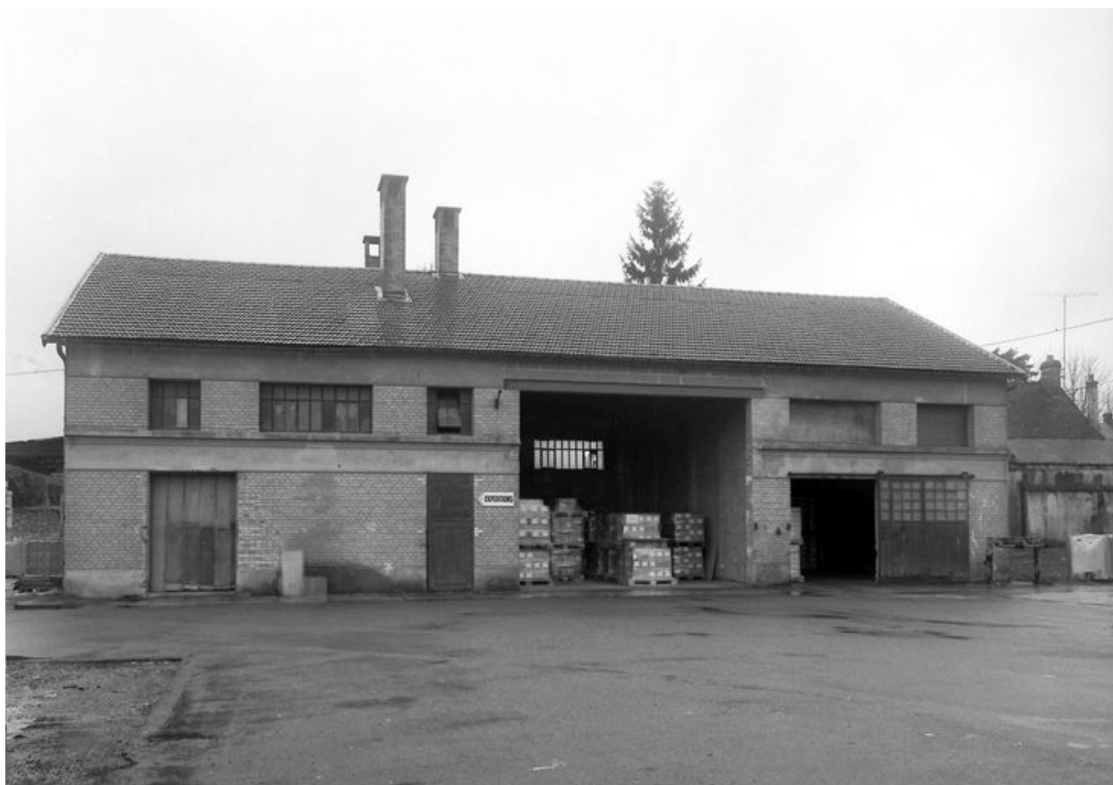
Salle des machines, façade latérale nord.
