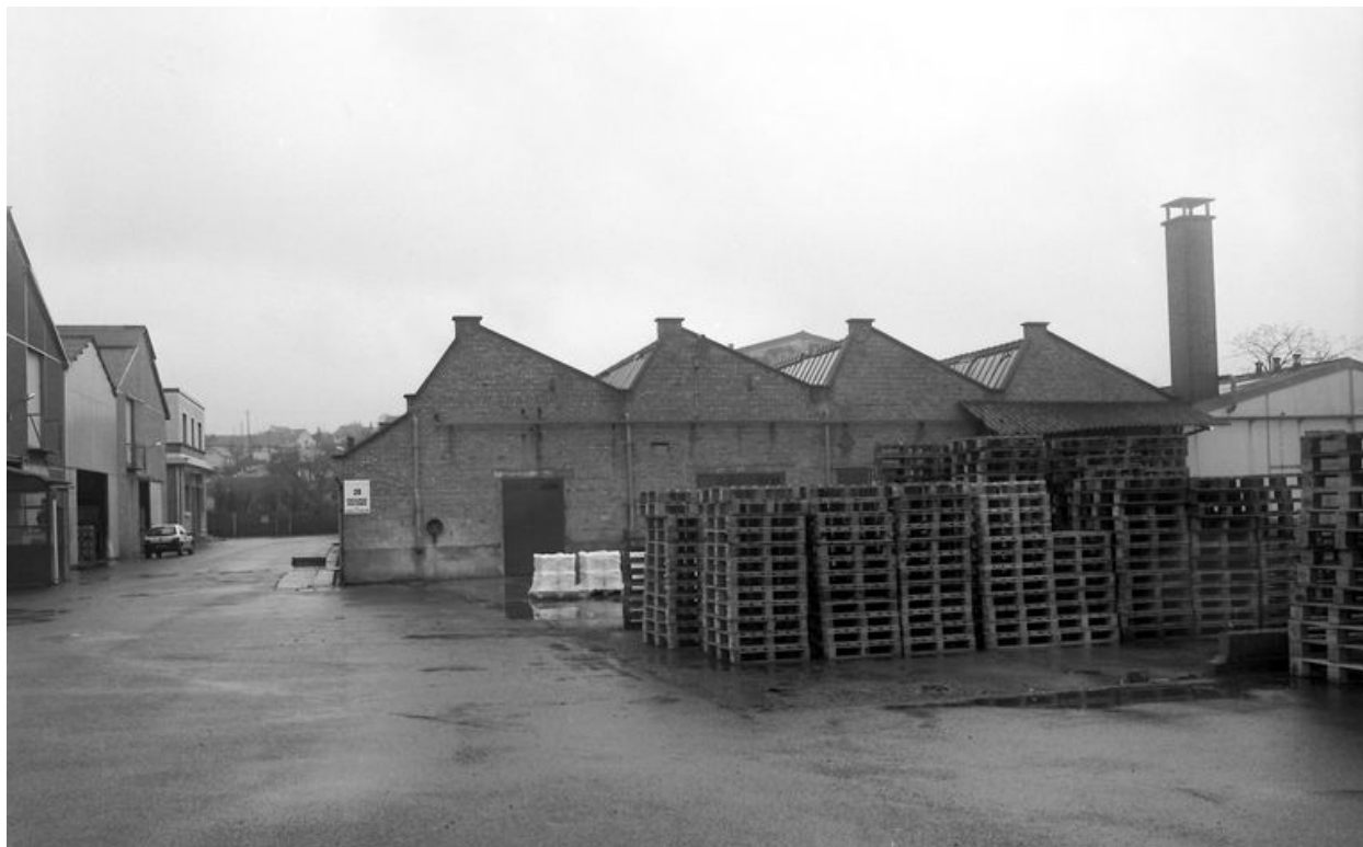
L'atelier de fabrication de l'usine de boutons, pignon sud avec shed.
