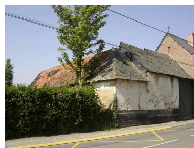
Vue latérale de la grange et du passage couvert. Phot. Inès Guérin IVR22_20058005860NUCA
