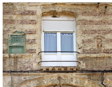
Détail de la façade, la mise en oeuvre en "rouge barre", une niche et un bas-relief représentant le bâtiment.
