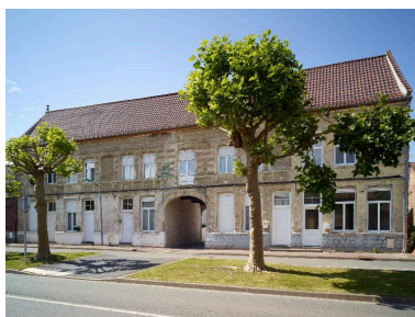
L'ancien bâtiment des douanes sur la place de la Croisette.
