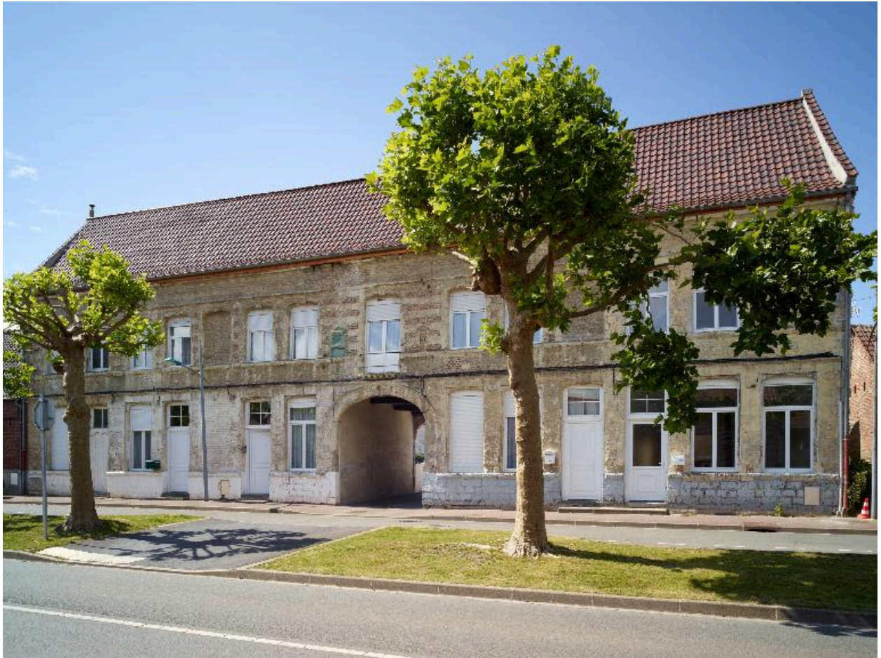
L'ancien bâtiment des douanes sur la place de la Croisette.
