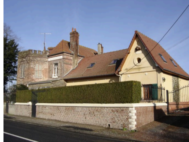
Vue latérale. Phot. Inès Guérin IVR22_20068005487NUCA
