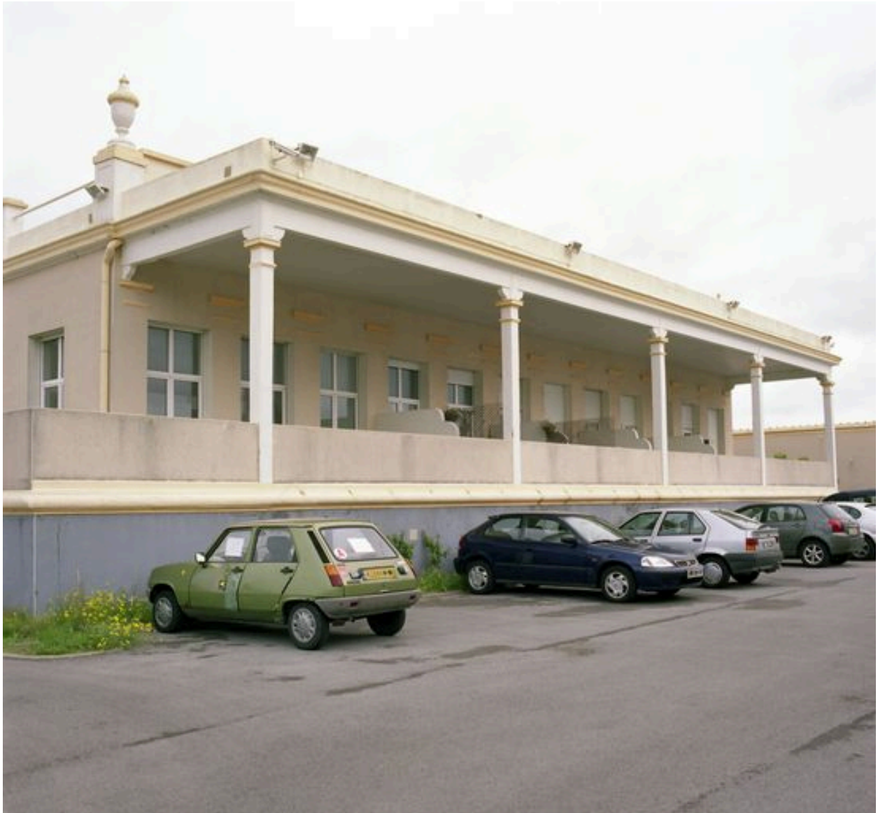
Elévation antérieure qui est dotée d'un solarium, vue générale prise de trois-quarts gauche.
