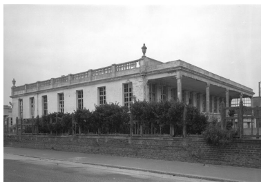
Elévation antérieure précédée de son solarium et élévation latérale gauche, vue d'ensemble. Phot. Eric Dessert IVR31_19816203866X
