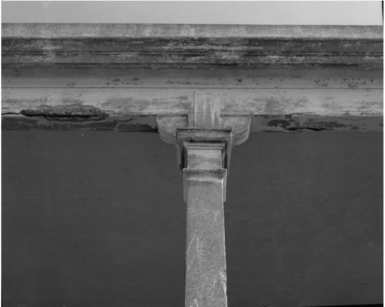
Elévation antérieure, détail du chapiteau d'un des piliers du solarium.
