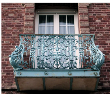
Détail du décor de fonte du garde-corps de balcon de l'habitation sur l'angle, dite Titania. Phot. Elisabeth Justome IVR22_20058002536NUCA
