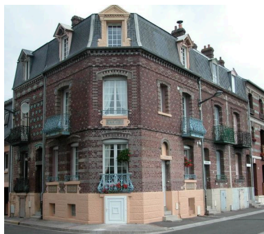
Vue d'ensemble des quatre habitations. Phot. Elisabeth Justome IVR22_20038005431NUCA
