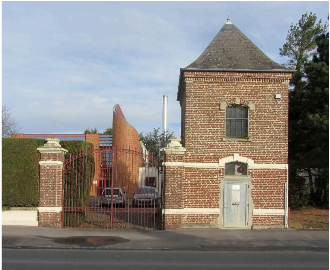
L'ancien portail et le pavillon d'entrée de la sucrerie.
