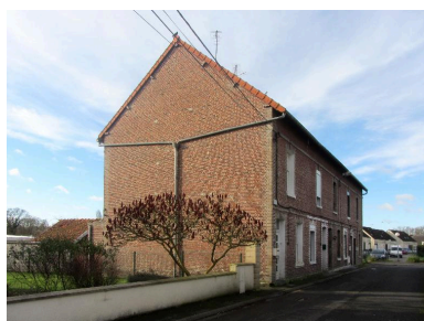
10-14, cité S.I.A.S., vue de trois-quarts. Phot. Bertrand Fournier IVR32_20168005034NUCA
