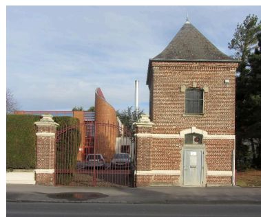
L'ancien portail et le pavillon d'entrée de la sucrerie. Phot. Bertrand Fournier IVR32_20168005026NUCA
