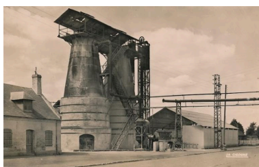
Les fours à chaux de la nouvelle sucrerie de Ham, carte postale, 1921 (coll. part.). Phot. Fournier Bertrand (reproduction) IVR22_20158006128NUCA
