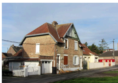
1-2 cité S.I.A.S, façade sur rue, vue de trois quarts. Phot. Bertrand Fournier IVR32_20168005031NUCA
