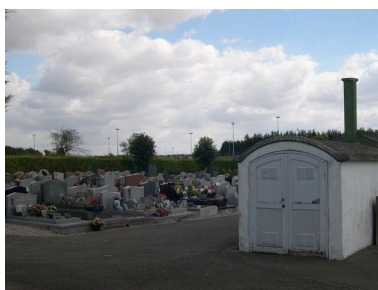
Vue du dépositoire. Phot. Isabelle Barbedor IVR22_20078010104NUCA
