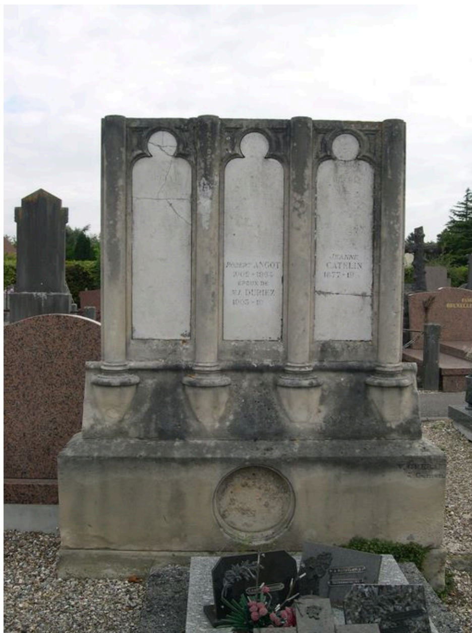
Vestiges d'une stèle réalisée, au début du 20e siècle par l'entrepreneur Guérard-Vast.
