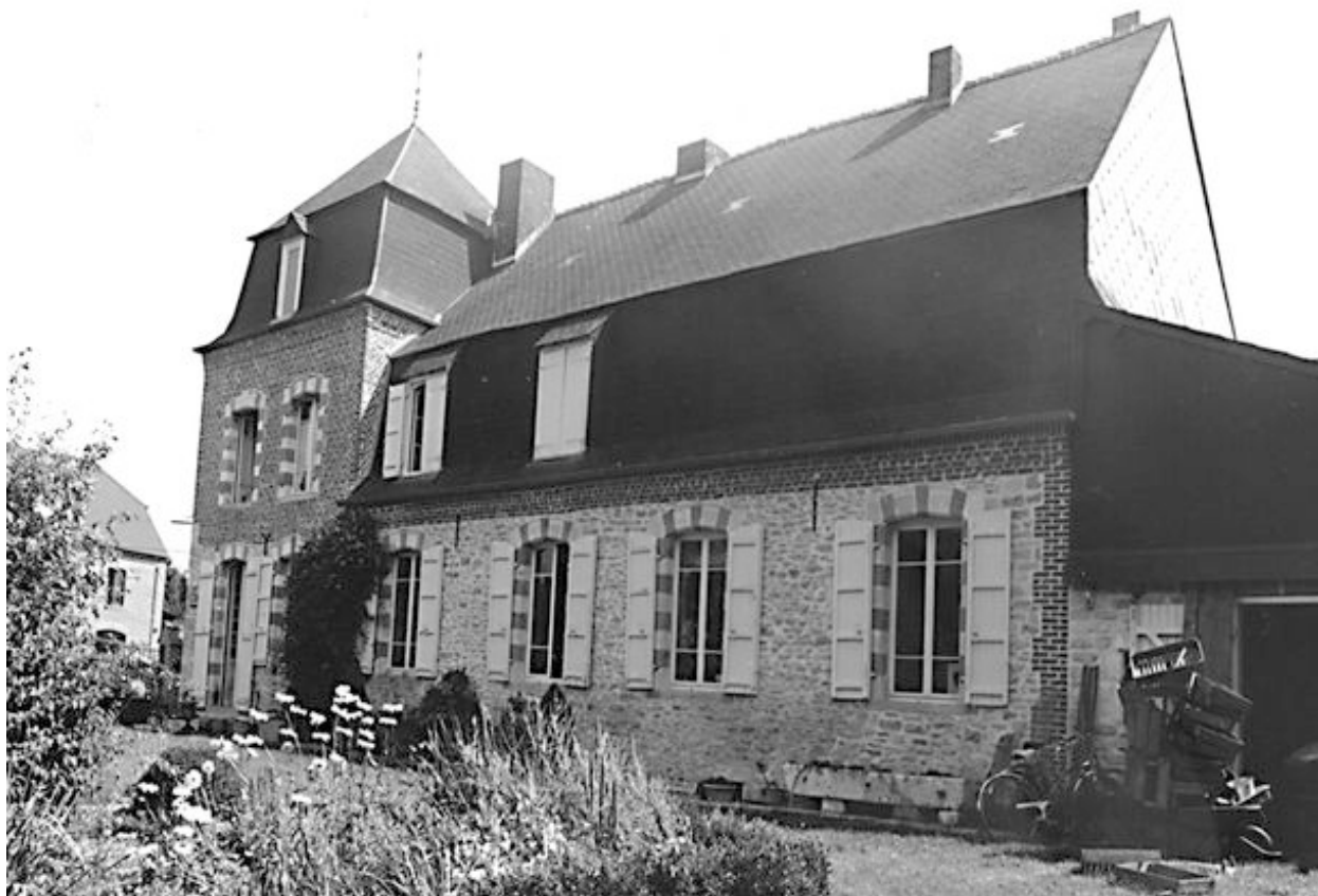
Elévation postérieure de l'aile ouest (sans doute la maison construite au milieu du 19e siècle pour M. Marlière).
