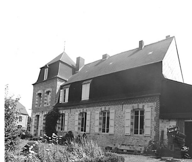
Elévation postérieure de l'aile ouest (sans doute la maison construite au milieu du 19e siècle pour M. Marlière).
