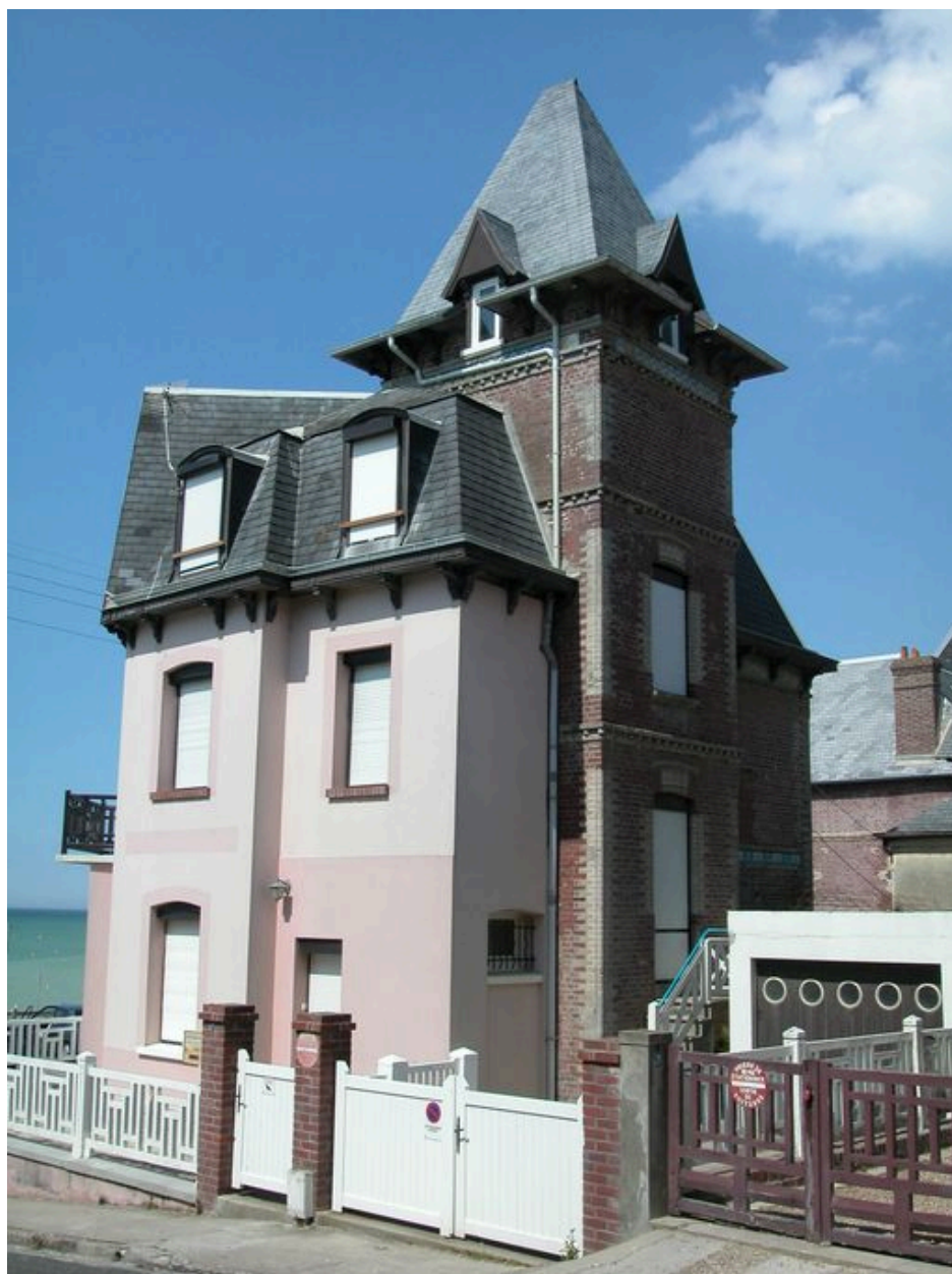
Vue de trois-quarts depuis l'avenue du Casino.
