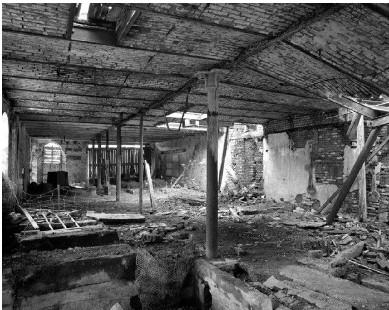
Vue intérieure de l'atelier (salle des piles ou salle de transmissions).
