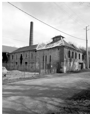
Vue partielle des ateliers (élévation ouest). Phot. Thierry Lefébure IVR22_19898000035X
