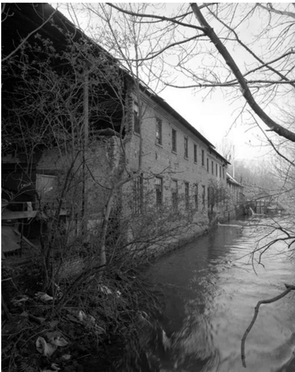
Vue de l'atelier (flanc nord).
