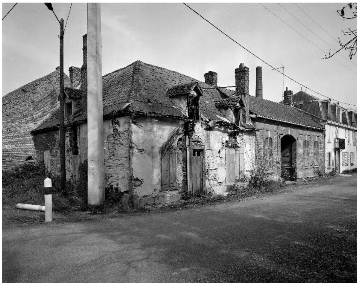
Vue partielle, flanc sud.
