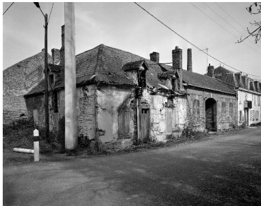
Vue partielle, flanc sud. Phot. Thierry Lefébure IVR22_19898000022V
