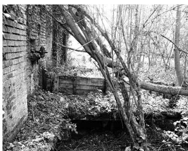
Vannes de décharge. Phot. Thierry Lefébure IVR22_19898000048X
