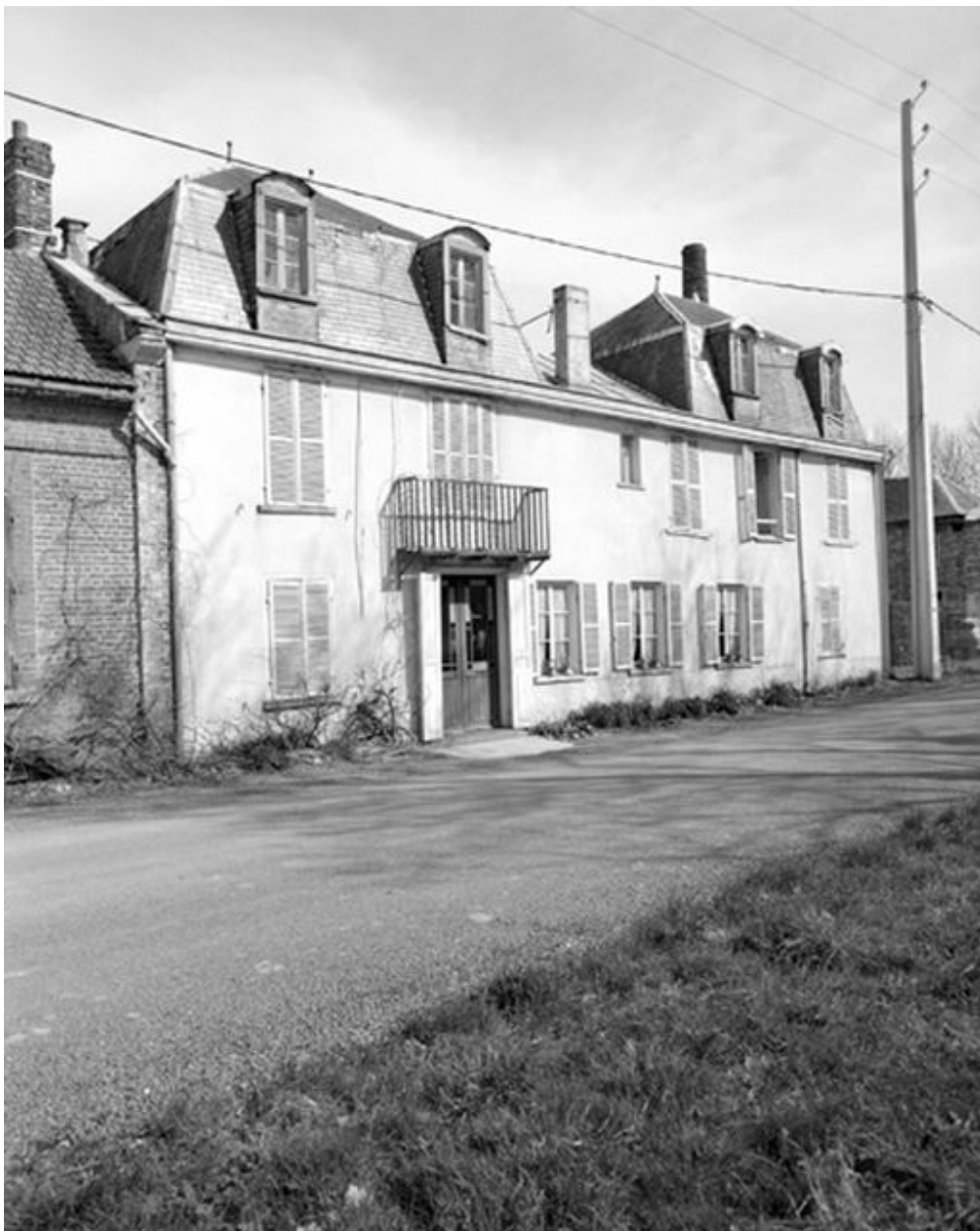
Logement patronal, élévation antérieure.
