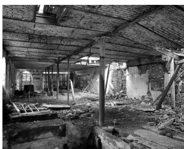
Vue intérieure de l'atelier (salle des piles ou salle de transmissions). Phot. Thierry Lefébure IVR22_19898000038X
