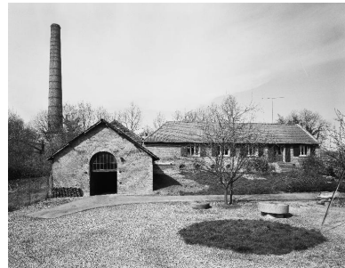
Ateliers de fabrication (commune de Plachy-Buyon). Vue générale, flanc est. Phot. Thierry Lefébure IVR22_19898000025V
