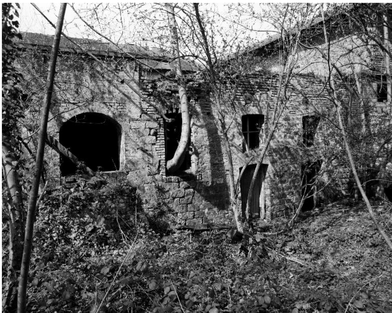
Atelier de fabrication, flanc est.
