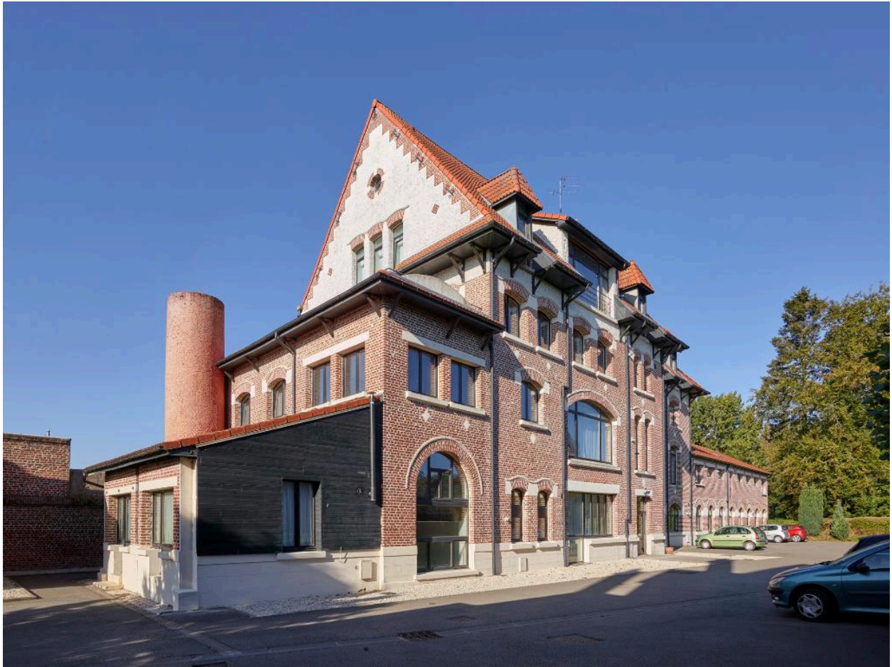
Façade sur cour de l'ancienne brasserie vue depuis l'entrée de la cour.
