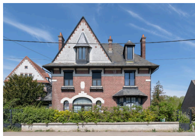
Vue de la façade principale de la maison de maître depuis la rue du Maréchal-Leclerc.
