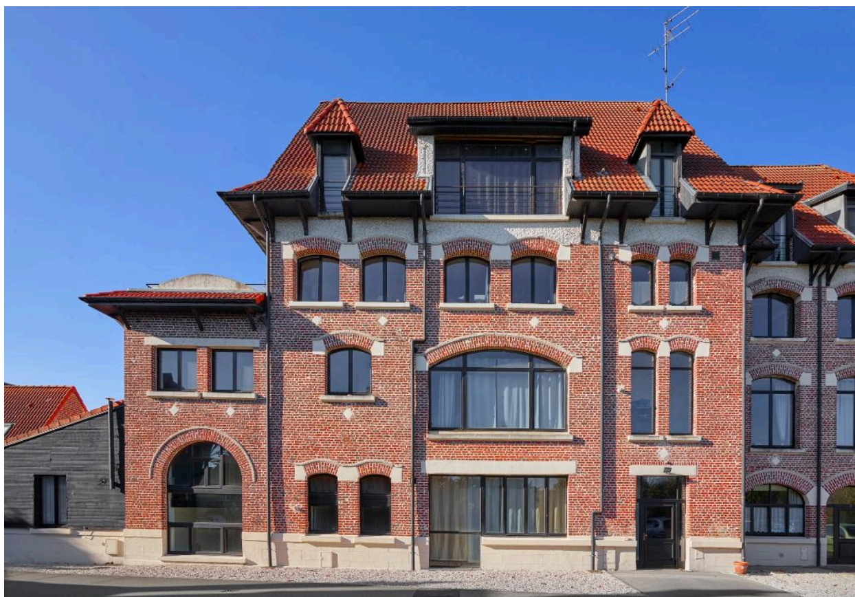
Partie gauche de la façade sur cour de l'ancienne brasserie vue depuis la cour.
