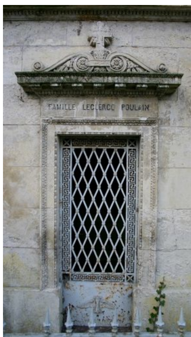
Détail du décor sculpté et de la porte en fonte ouvragée (N49) Phot. Caroline Vincent IVR22_20088000310NUCA
