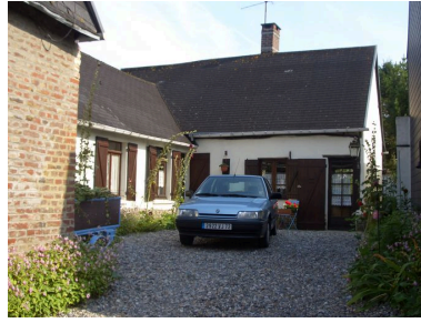
Vue du logis. Phot. Inès Guérin IVR22_20078005250NUCA
