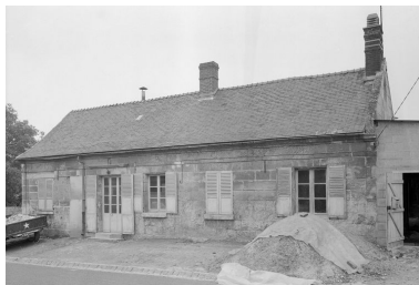
Elévation antérieure. Phot. Jean-Michel Perrin IVR22_19846001003X
