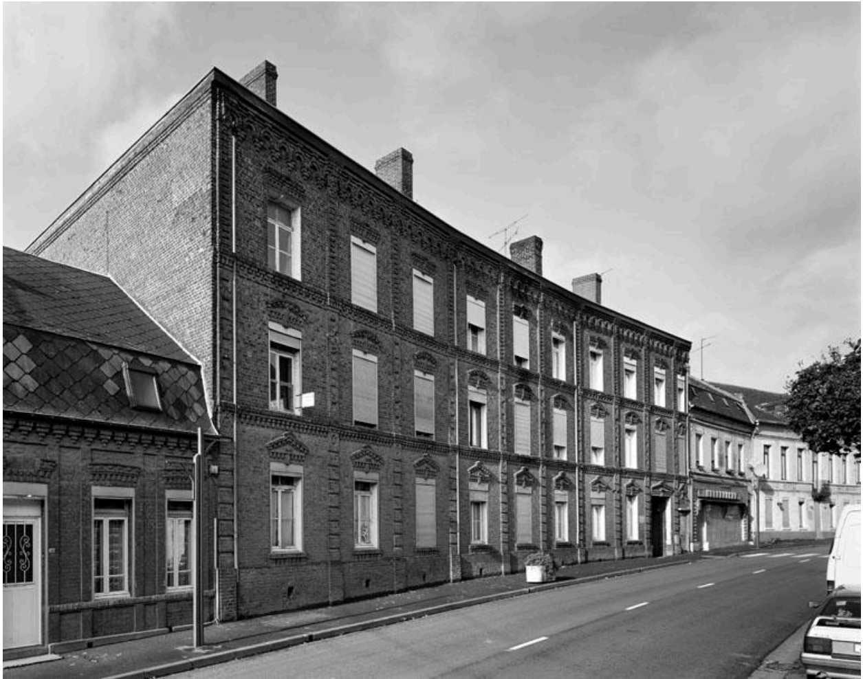
Vue de la façade sur rue.
