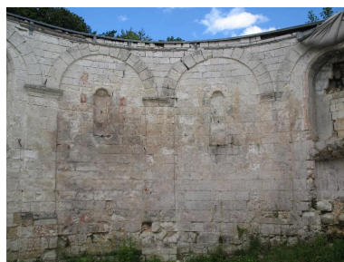
Détail de l'abside, côté nord. Phot. Bertrand Fournier IVR22_20128005044NUCA
