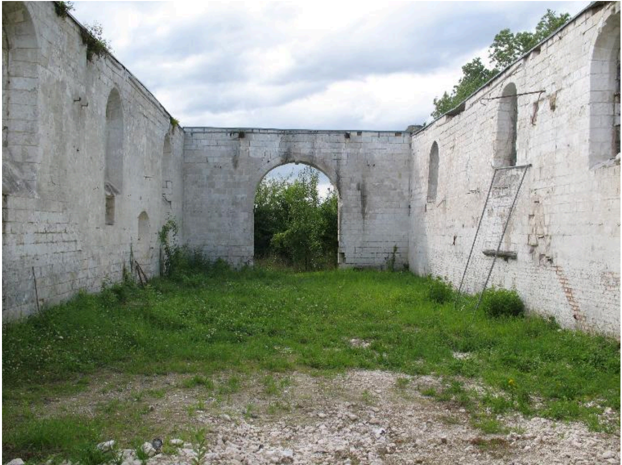
Vue intérieure de la nef, vers l'ouest.
