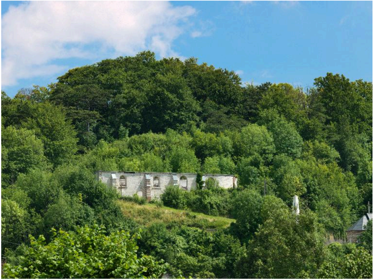
Vue d'ensemble de la ruine de l'église paroissiale, accrochée au flanc sud de l'oppidum.
