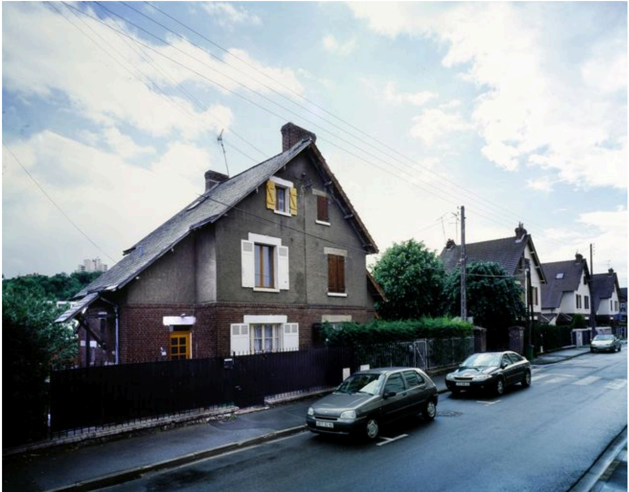
Vue générale de trois maisons jumelées sur la rue Voltaire.
