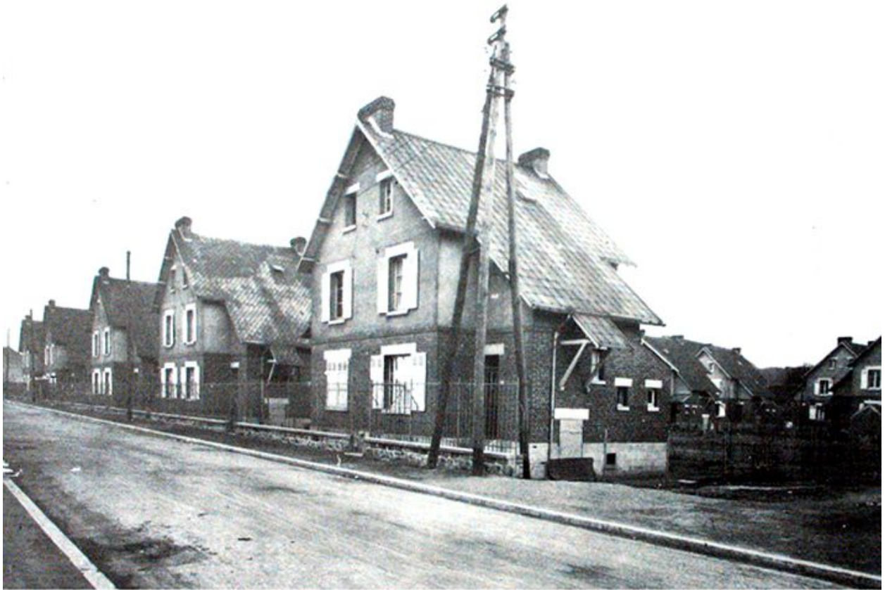
La cité du zinc lors de l'achèvement des travaux en 1926 (AC Creil).
