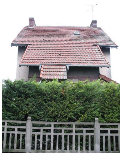
Successions de toitures. Phot. Clarisse Lorieux IVR22_20076005087NUCA
