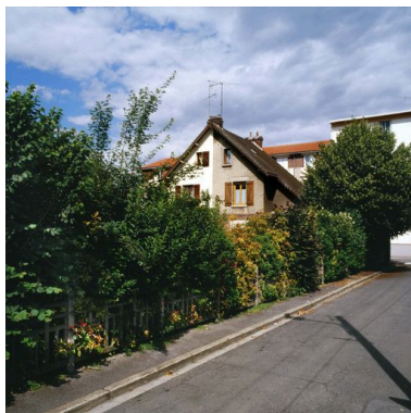
Façade antérieure des maisons jumelées. Phot. Thierry Lefébure IVR22_20076000001XA
