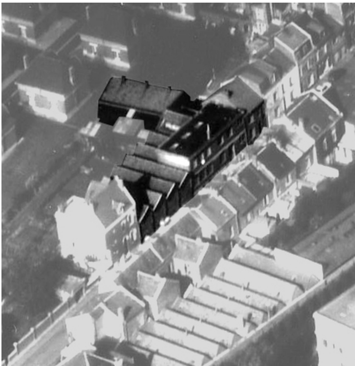
Vue aérienne de l'usine en 1989.
