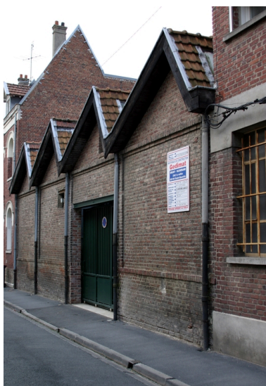
Façade antérieure des ateliers de 1922. Phot. Frédéric Pillet IVR22_20040200960NUCA
