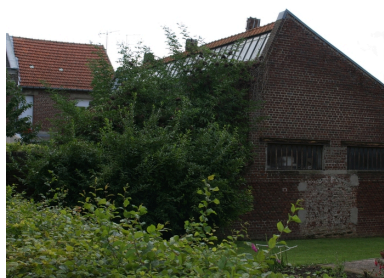
Façade antérieure des ateliers, vus depuis les béguinages voisins.
