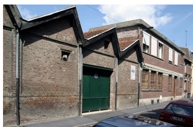
Façade antérieure de l'usine : à gauche, couverts de sheds, les ateliers de 1922, à droite, sur deux niveaux, les ateliers agrandis en 1946.
