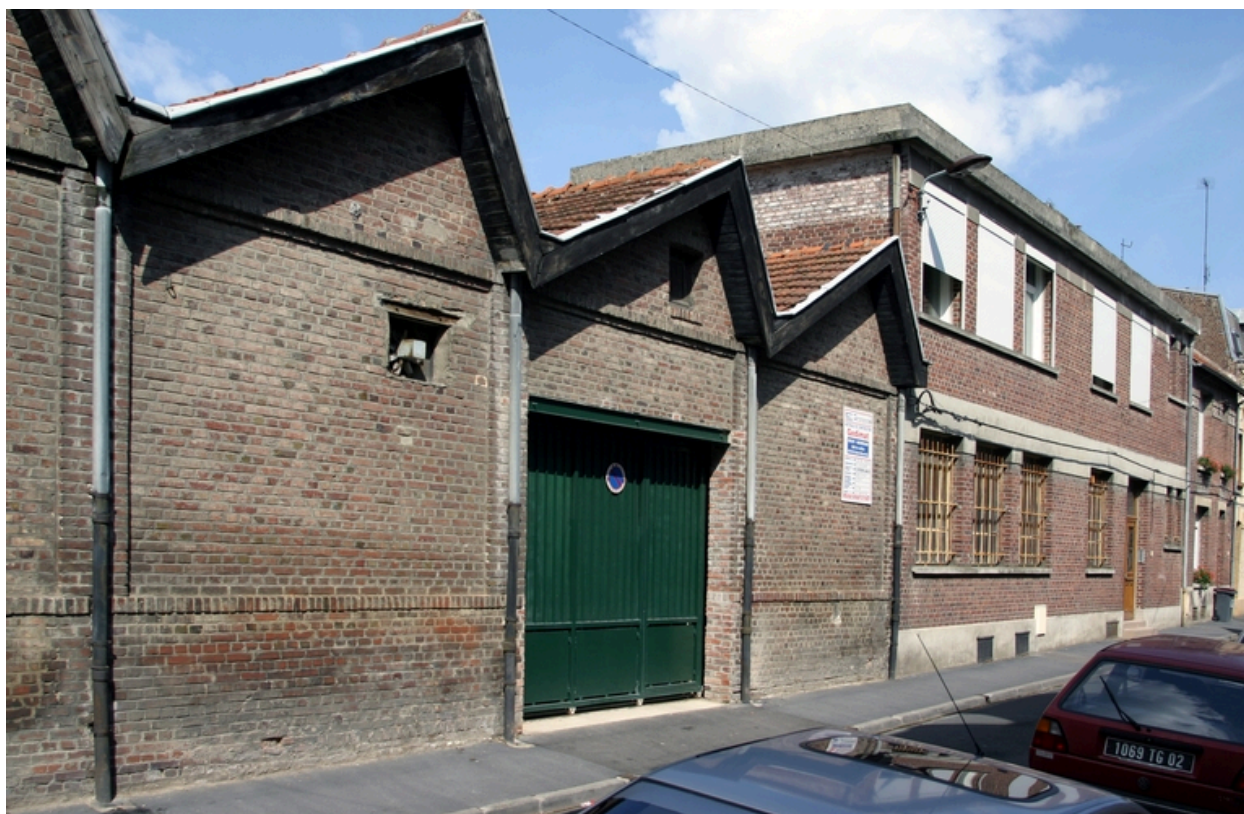
Façade antérieure de l'usine : à gauche, couverts de sheds, les ateliers de 1922, à droite, sur deux niveaux, les ateliers agrandis en 1946.
