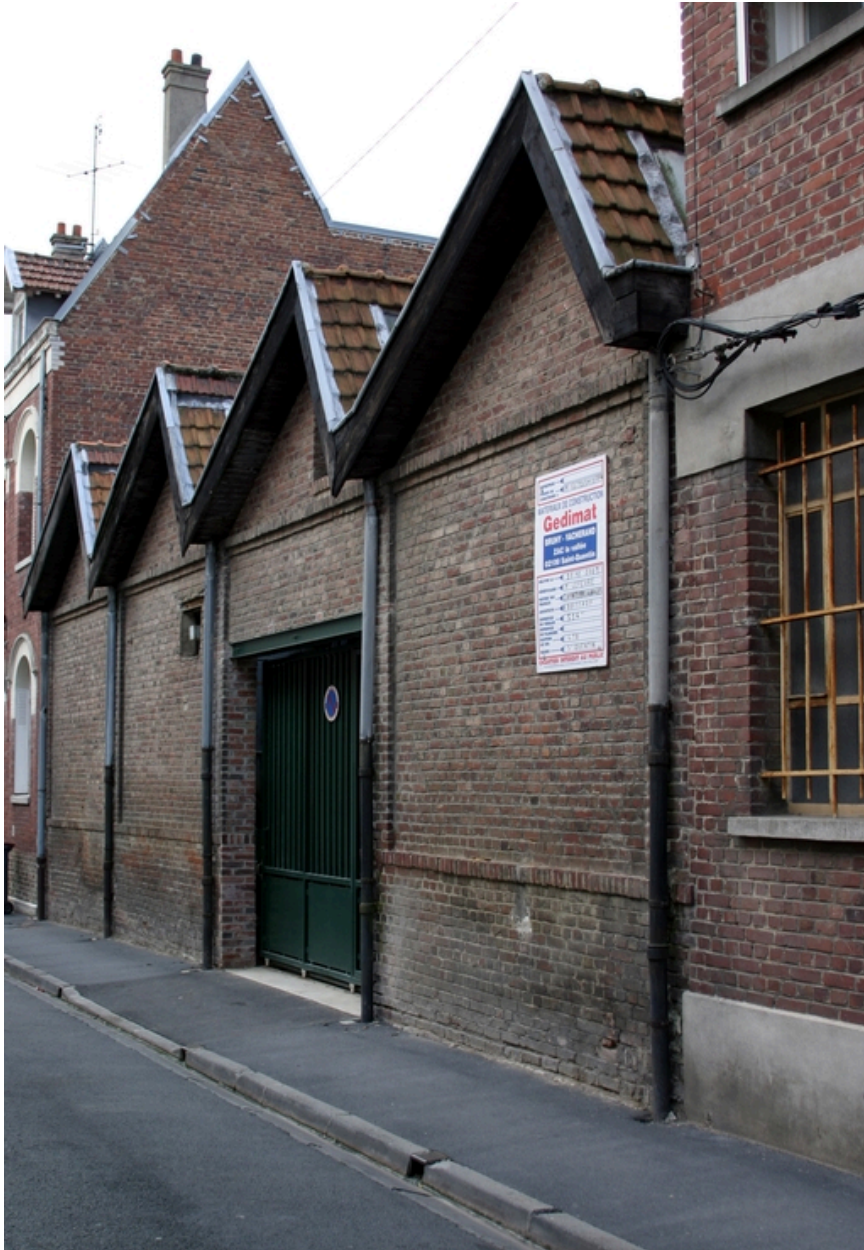
Façade antérieure des ateliers de 1922.
