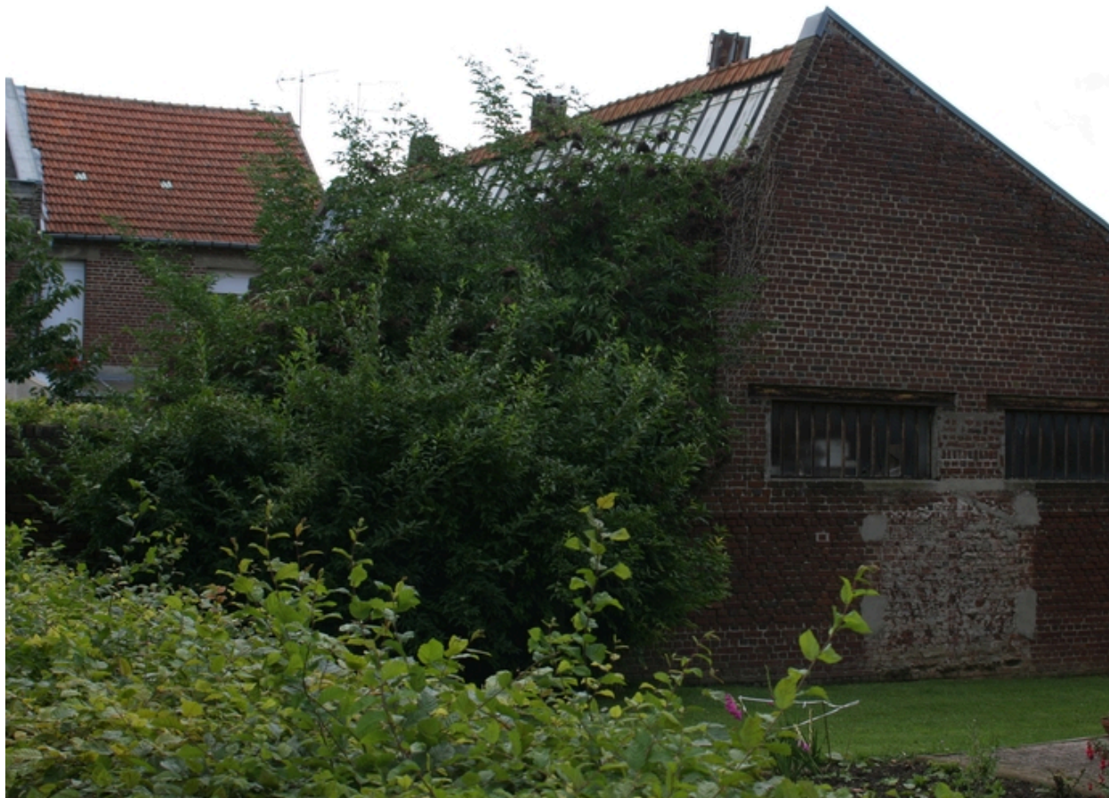
Façade antérieure des ateliers, vus depuis les béguinages voisins.
